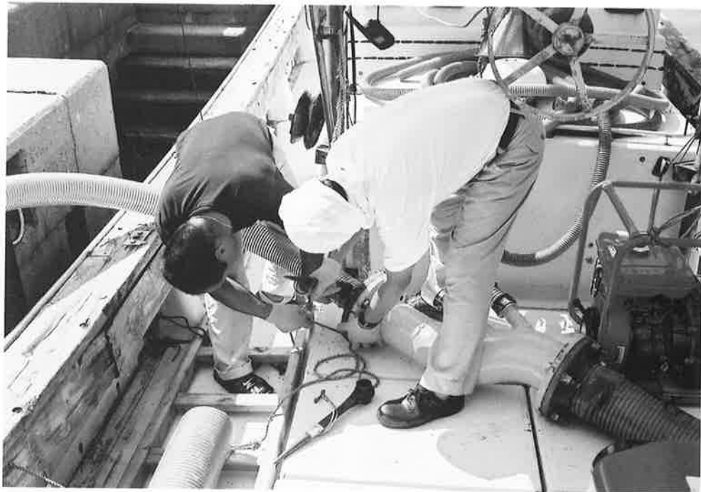
PL.11 ドレッジ本体と接合された吸引ホース
