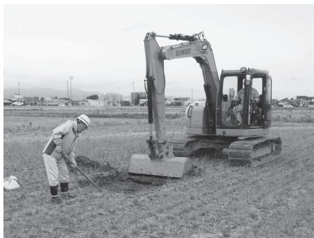
写真 1 調査風景（蓮瀧地区）
