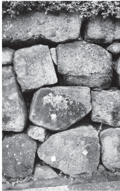
写真17 堀川石垣S12-1 (S③a・b)
