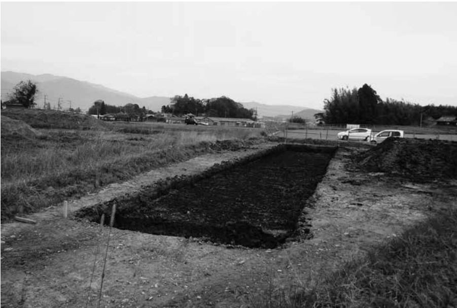
(2) E-3b区全景(西から)
