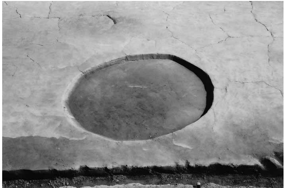
(2) A トレンチ第 2 遺構面土坑 S K32(北西から)
