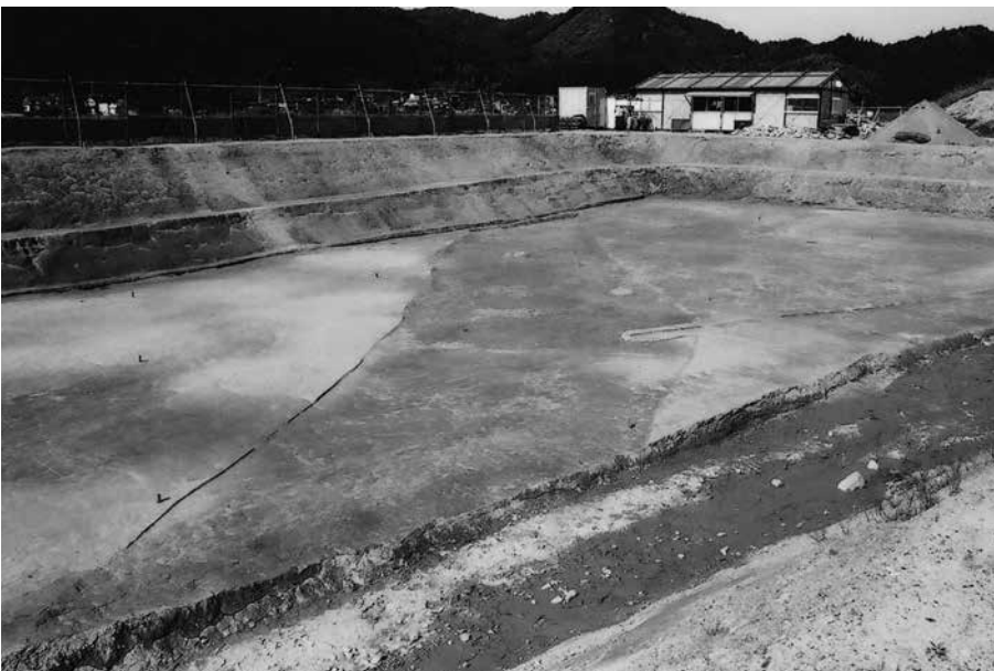
(3) A トレンチ第 2 遺構面 S D 22・S X 23 全景(南西から)
