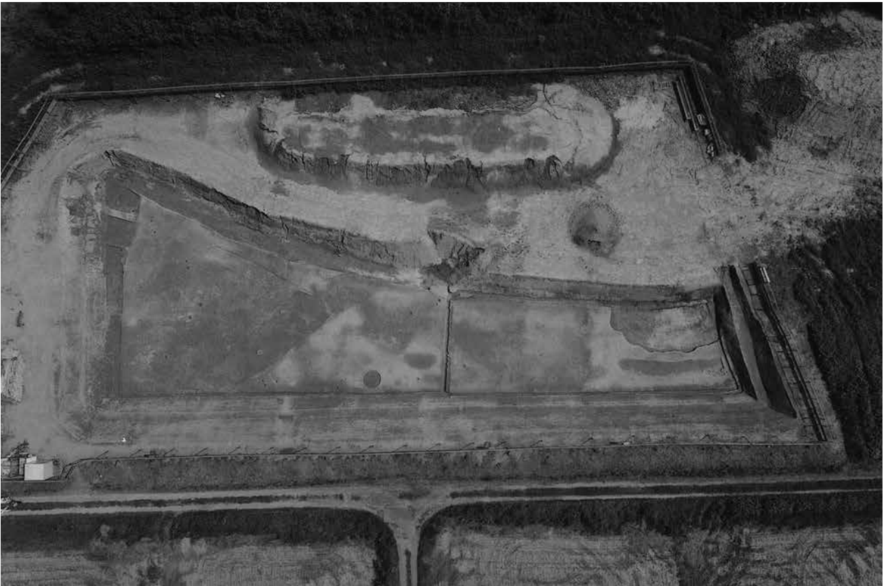
(2) Aトレンチ第2遺構面調査地全景(右上が北)
