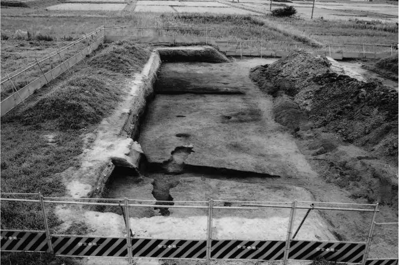
(1) 調査区下層全景(北西から)
