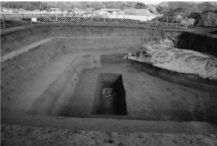
(3) B 1 トレンチ第 3 遺構面断ち 割り調査状況 (南西から)
