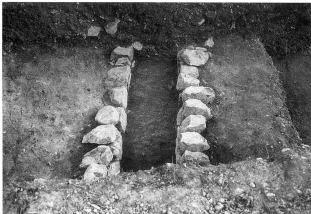
G トレンチ排水溝
