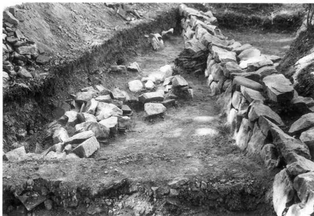
Cトレンチ石垣検出状況
