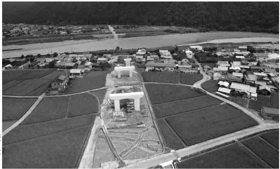
3. 第2次調査 調査地全景 (西から)
