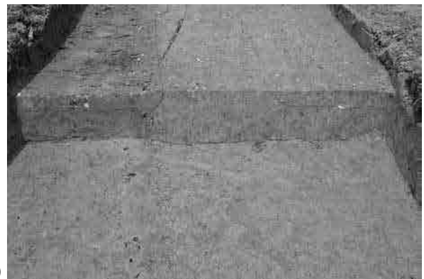
5. 調査区 3-5-2 畦畔状遺構土層 (北から)
