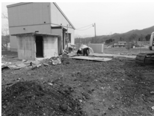
諏訪原 C 遺跡調査地 (西から)
