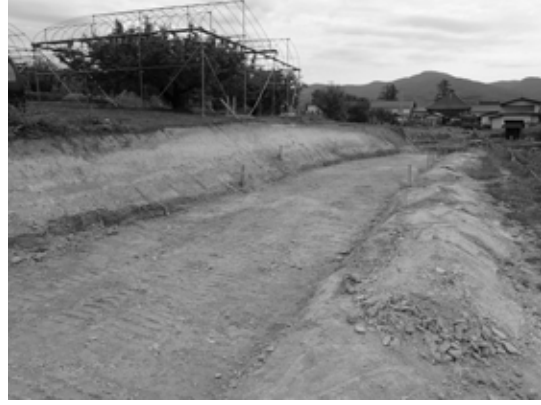
宮内字鐘小屋二 工事状況（西から）
