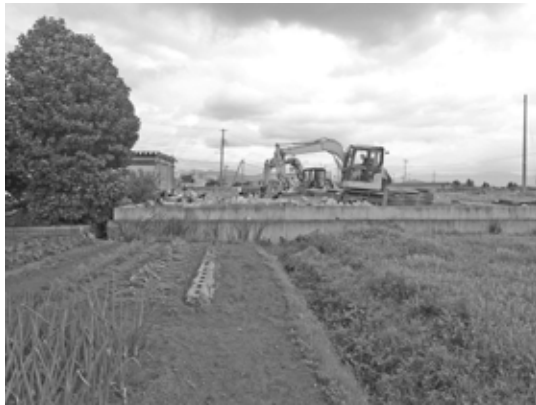
竹原字石仏 工事状況（西から）
