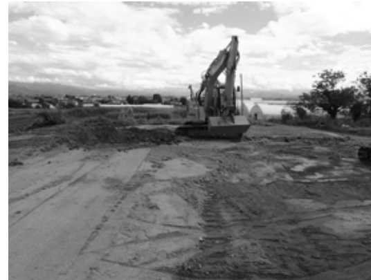
和田字東前田 工事状況（北から）
