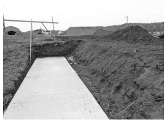
漆山字東寺町三 (1) 擁壁工事 (東から)
