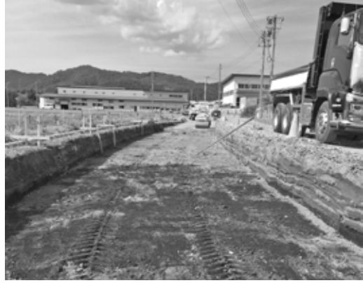
漆山字東寺町三(2) 工事状況（南から）
