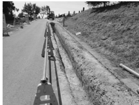
長岡山遺跡 工事状況（東から）
