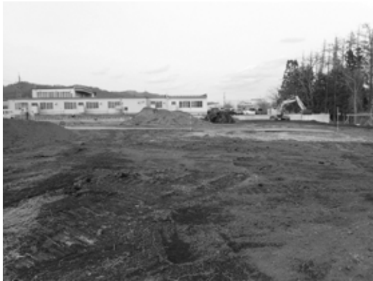
漆山字東寺町三 (1) 工事状況 (南から)
