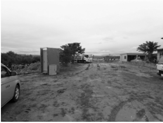
宮内字内原四 工事状況（東北から）
