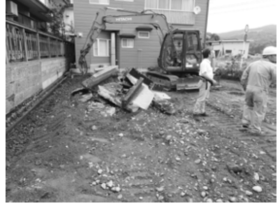
宮内字塔ノ越 工事状況 (南から)
