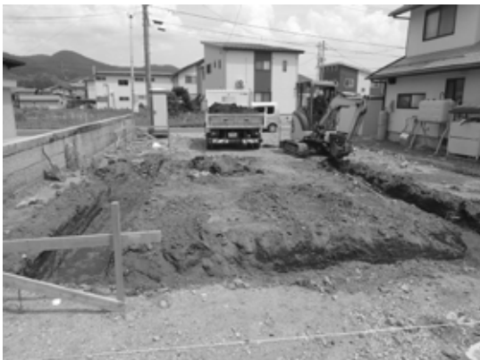
宮内字黒木一 工事状況 (西から)
