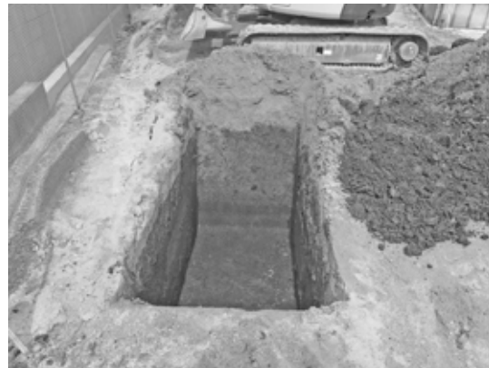
漆山字西屋敷一 TT1 (南から)
