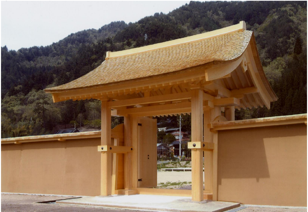
写真5 下館跡復元主門（南西から）
