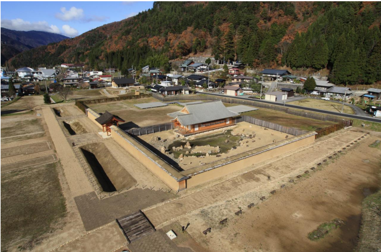
写真4 下館跡堀内地区全景（南西から）
