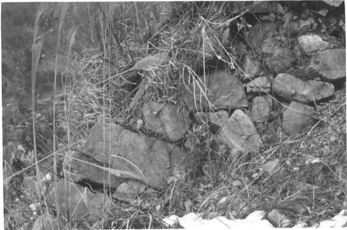
資料 35 公園整備前の東町城跡櫓台石垣 撮影年不明
