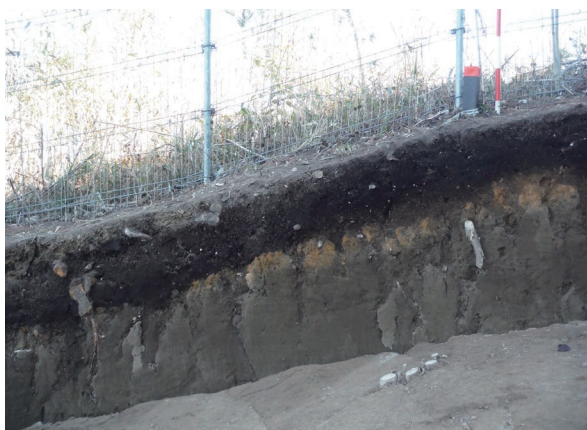
251区東壁土層断面（西より）
