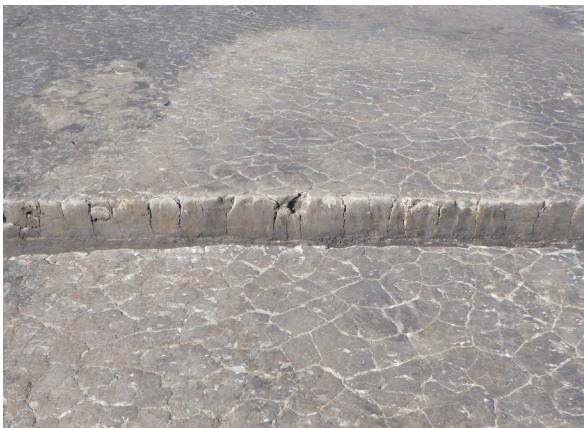
畦畔状遺構A群土層堆積状況(南東より)
