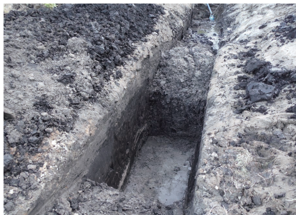
Tr3 掘削状況(南より)
