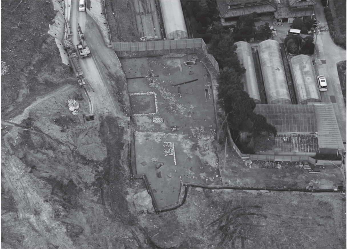
上段南地区全景（南から）
