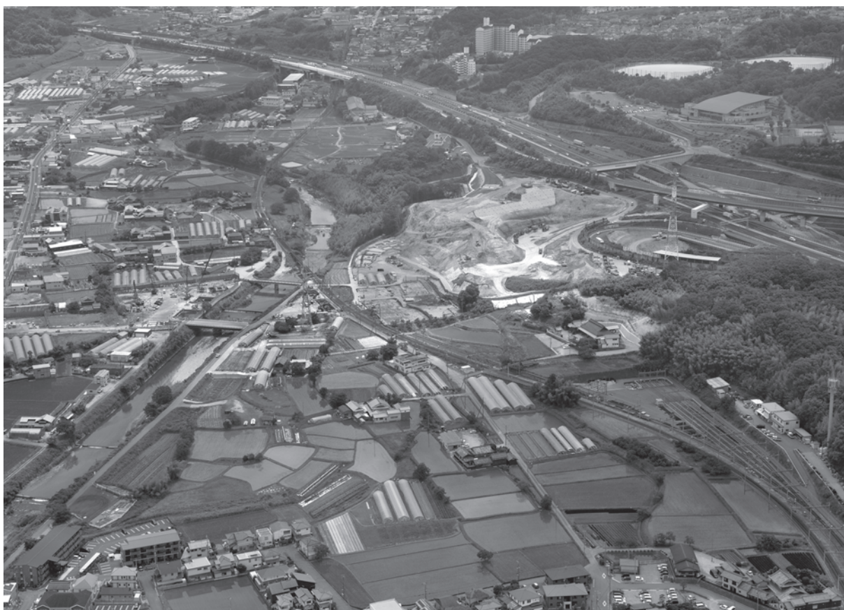
調査地区遠景（北から）
