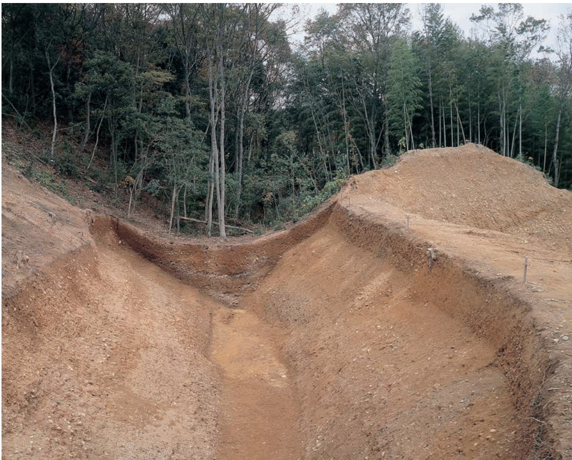
堀切 全景 南から
