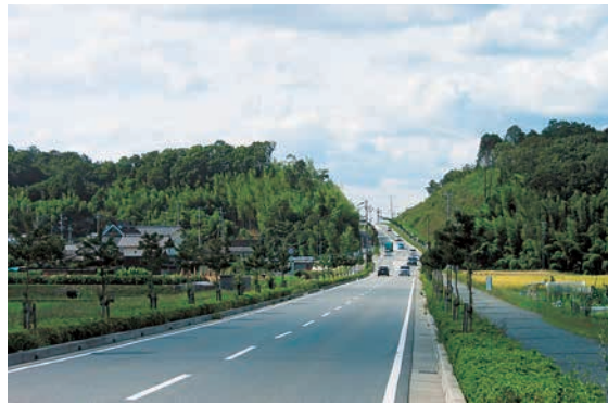
第15図 竣工後の吉田住吉山遺跡群遠景（東から）
