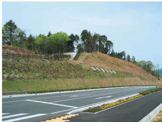
第16図 竣工後の吉田住吉山遺跡群近景（南西から）
