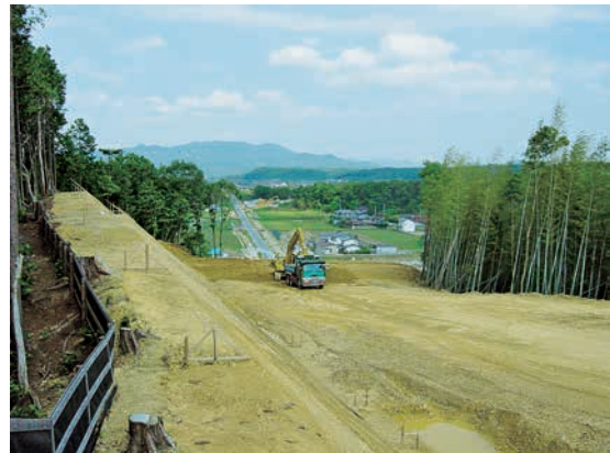
第13図 工事中の吉田住吉山遺跡群
