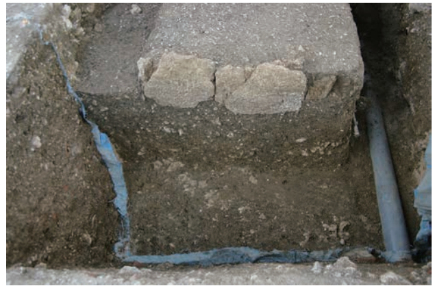
3. トレンチ4溝1②(東側、北から)
