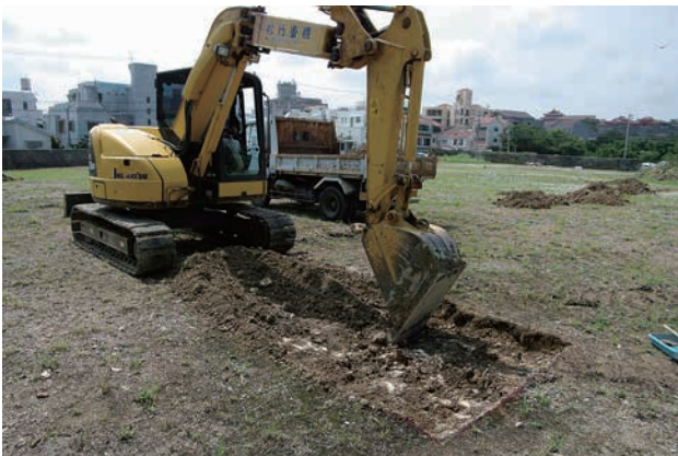
5. トレンチ1重機掘削作業
