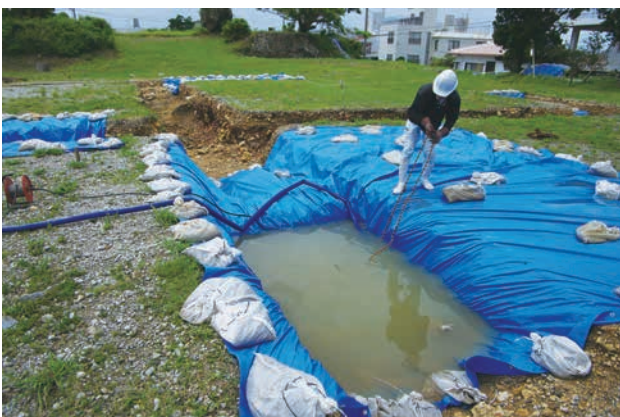
7. 台風通過後水抜き作業
