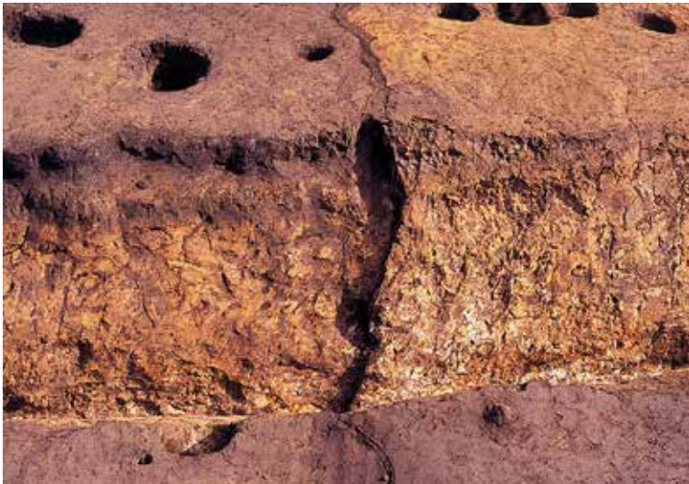
1区1号溝地割れ状況（西から）
