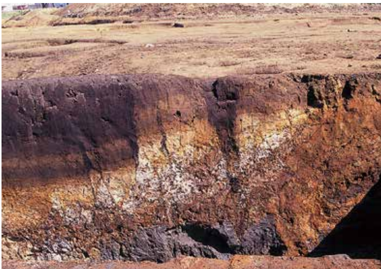
1区地割れ状況（西から）
