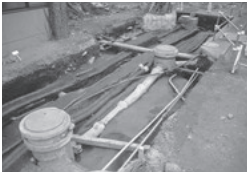
C. 遺物包含層検出状況（南東より）
