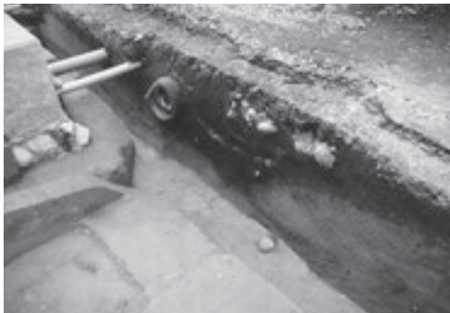
K. H 24 HP 04 (セクション：南西より)
