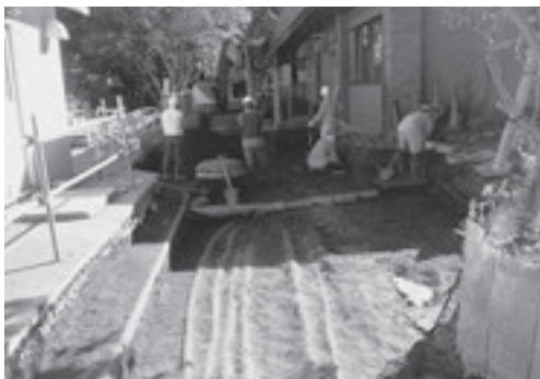
A. 表土掘削状況（北より）
