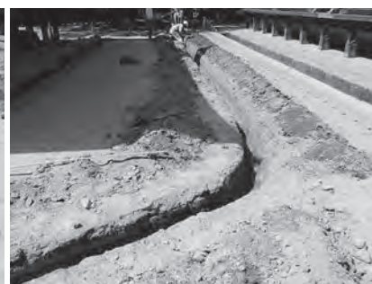
第52図 掘削状況 C地点
