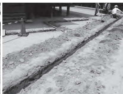
第51図 掘削状況 B地点
