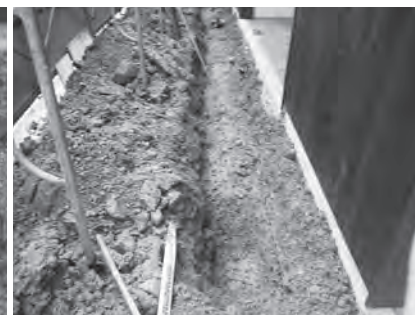
第99図 掘削状況
