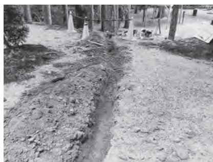
第50図 掘削状況 A地点
