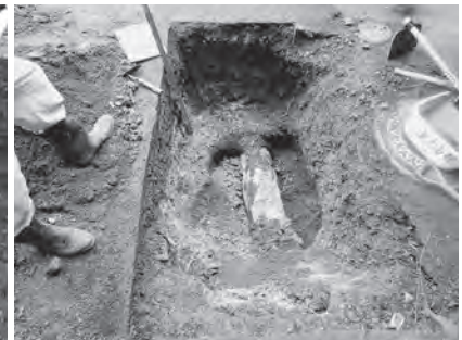
第116図 掘削状況
