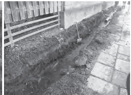
第120図 掘削状況
