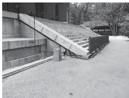
第73図 調査地全景（掘削前）
