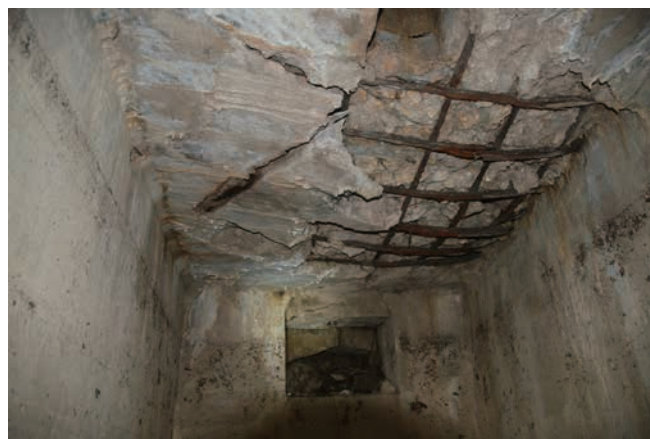
弁ヶ嶽の通信所跡（左：近景 右：内部天井の鉄筋） 鉄筋や厚いコンクリートなど、頑強な構造となっている。
