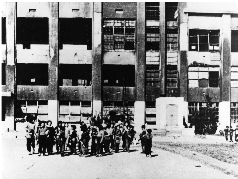
写真3 ガラスは吹き飛び焼けただれた「白亜の校舎」
