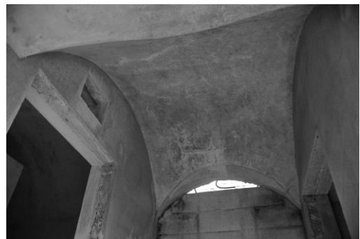
防空壕 現況 (平成28年3月時点)
