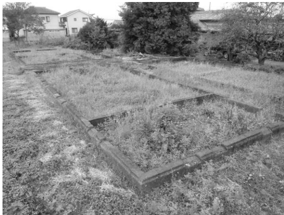
残存する基礎部分（南東から）
