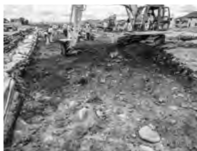
重機による掘削作業
