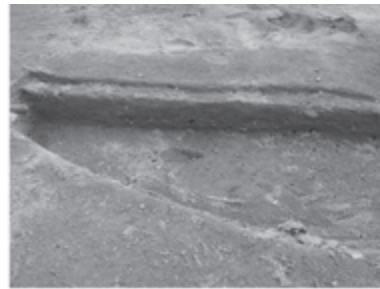
②断面状況
