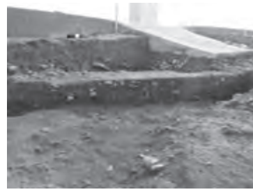
③断面状況
