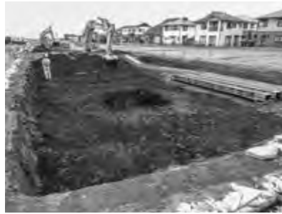
重機による掘削作業
