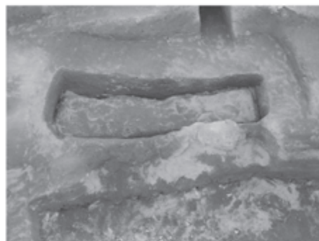
⑥掘方完掘状況
