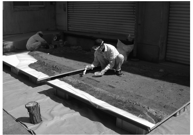
fig.198 土壌強化剤塗布作業
