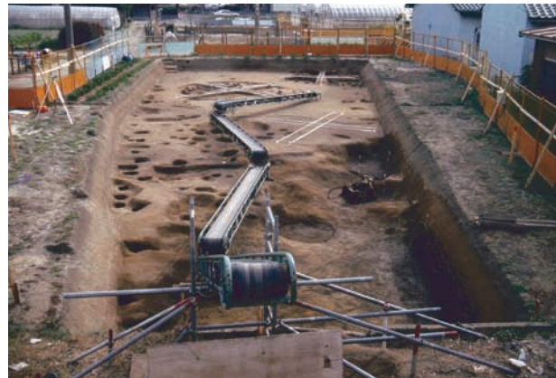
C 区 (11-2 地点) 遺構検出 (北西から)
