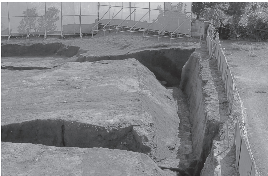
第 1 号堤防跡 表 法 面
