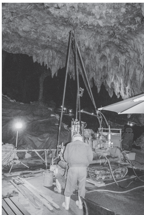
図3-20 2013年11月地質調査の様子(DP-E(2013))
