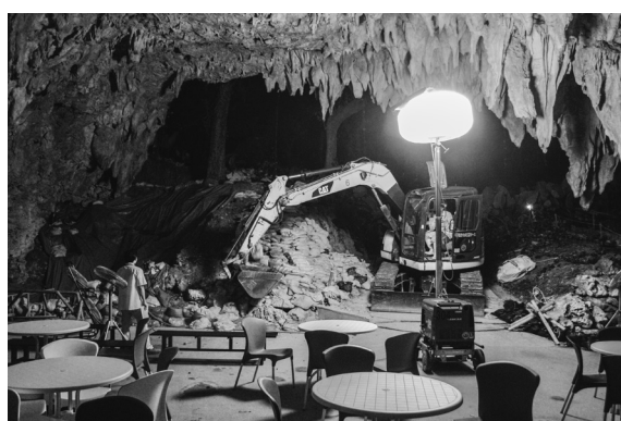
図3-15 2013年8月排土除去作業
