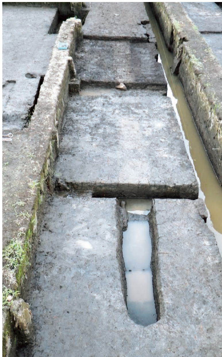
S D 2166 溝跡精査 (南→)
