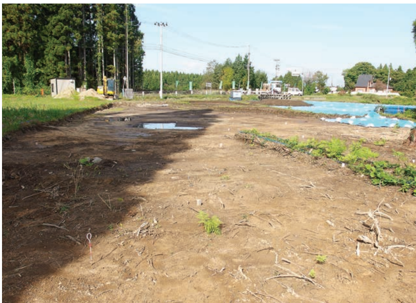
2 調査区南半部 表土除去後近景(南東→)
