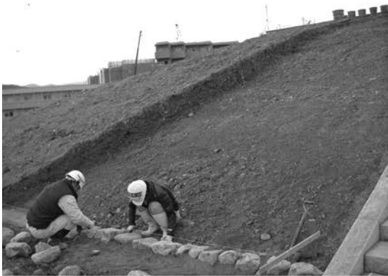
3 基底石配置作業
