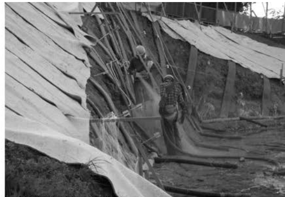
10 連続繊維補強土工-2
