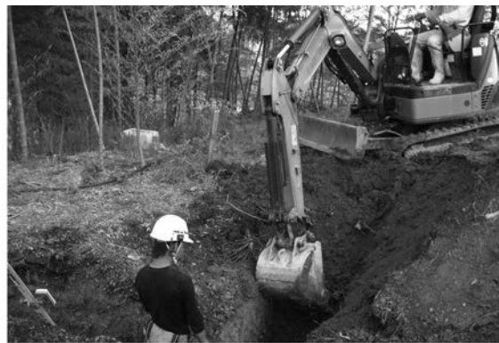
2 バンブーバリア埋め込み溝掘削工
