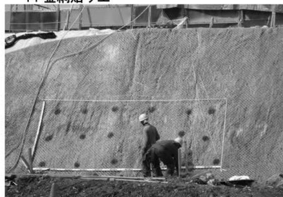
16 ジオピン設置工-2
