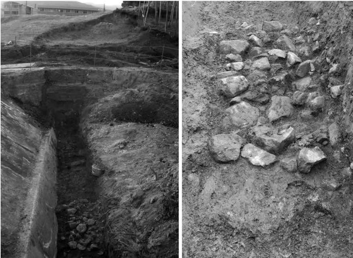
(1) 保存整備工事その2 L地区前方部東辺墳丘裾葺石検出状況（東から）
