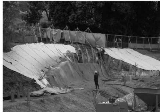
12 連続繊維補強土工-3
