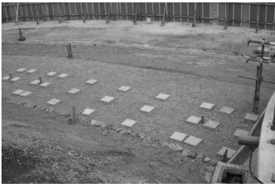
2 木道スロープ基礎設置 (南東から)
