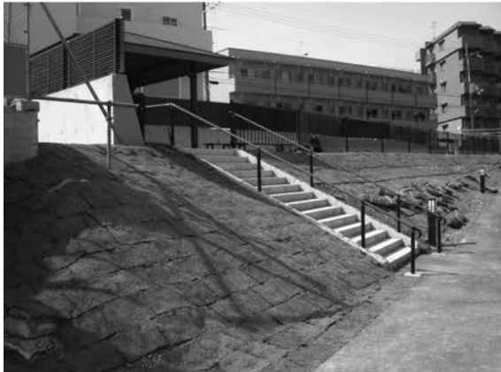
3 東屋、階段設置状況
