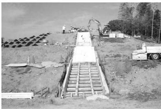
5 石階段コンクリート基礎工
