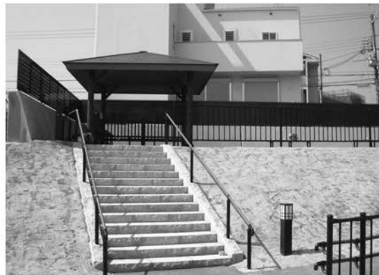
6 休憩広場、東屋完成状況
