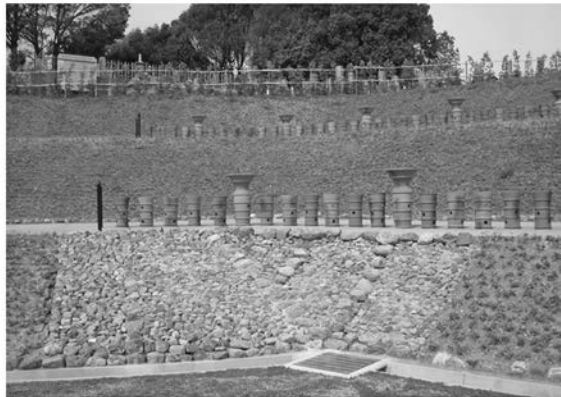
4 西くびれ部葺石復元工修了状況
