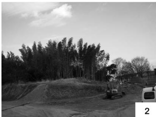
第77図 保存整備工事その1 前方部の竹木伐採除根作業風景
