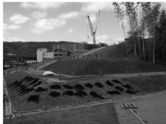
4 コクマザサ植栽工 (植栽土壌改良)
