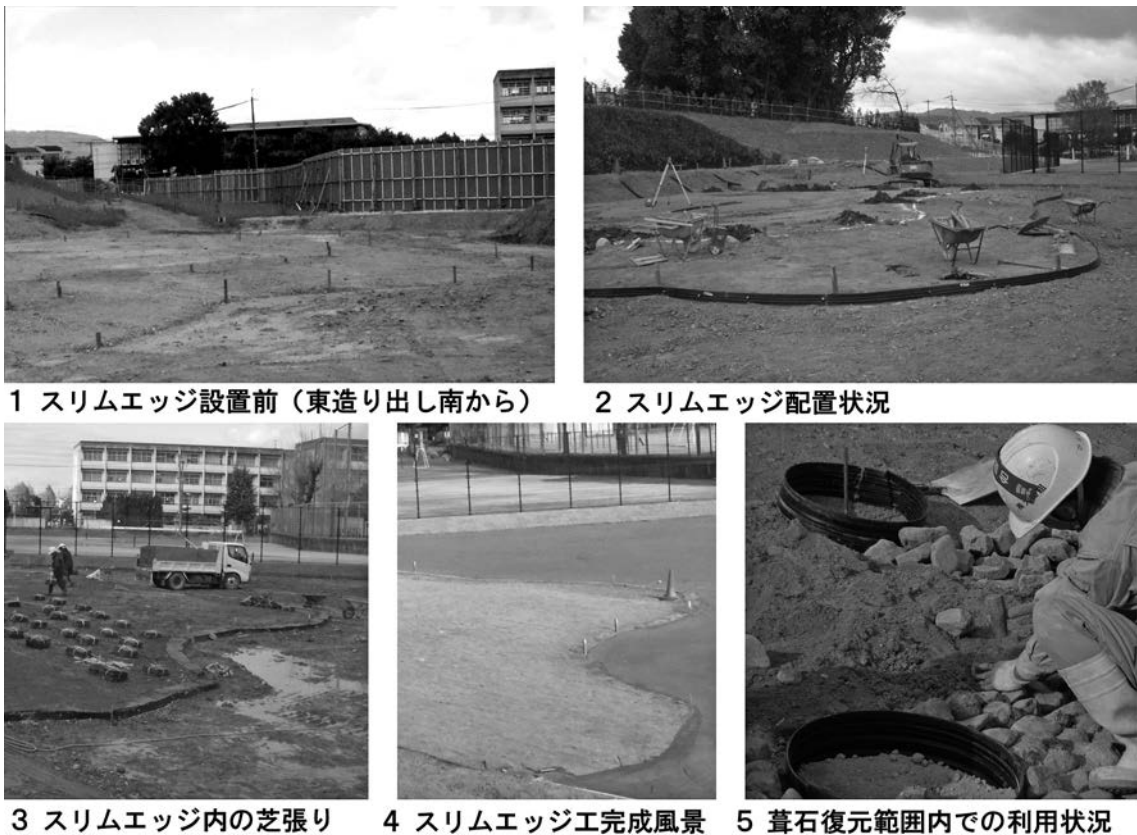
第96図 スリムエッジ設置工
