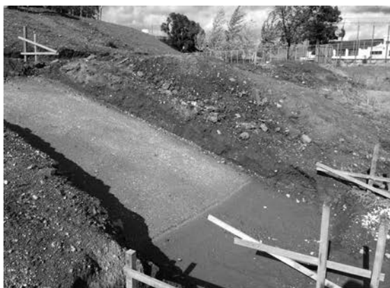
1 石階段基礎掘削工
