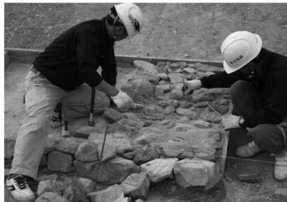
6 葺石復元（葺石敷きつめ作業）
