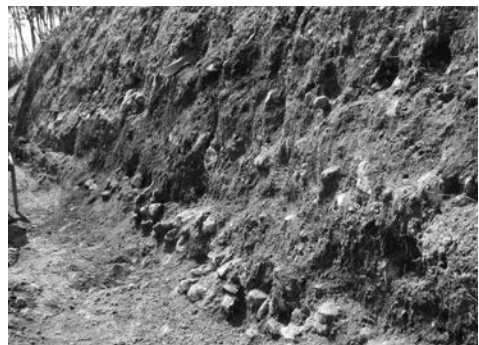
第48図 ジオファイバー基礎工 西壁面中世礫層
