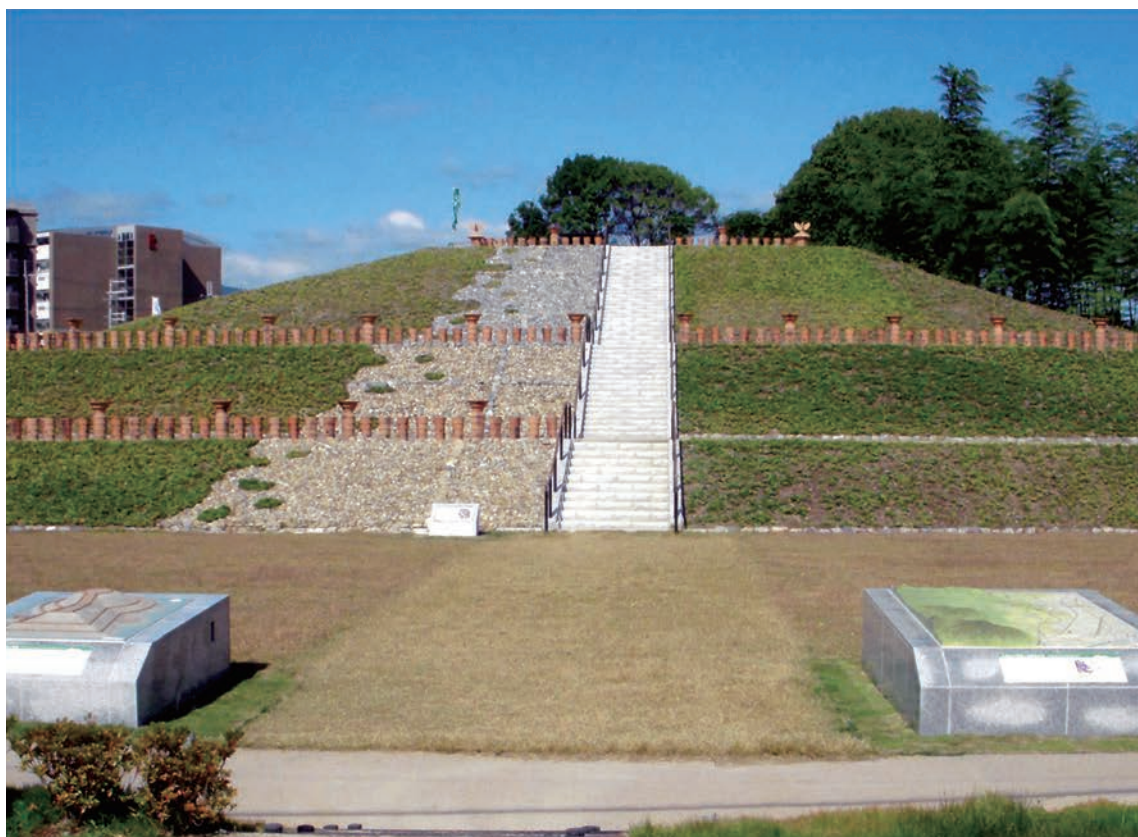
(2) 前方部前面の整備状況（南東から）
