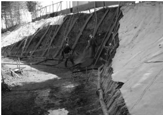
9 連続繊維補強土工-1
