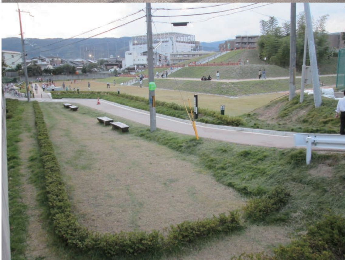
第 208 図 周濠南部の整備 上一周濠南部の整備前景観（東から）。下一周濠南部の整備状況（東から）
