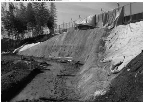
15 ジオピン設置工-1
