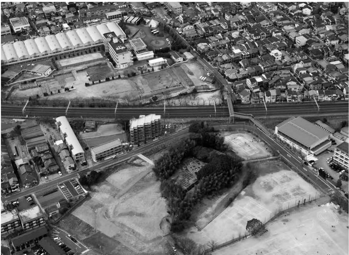
(2) 平成 24 (2012) 年整備工事その 1 完了状況 (南東から)
