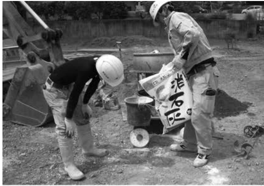
1 二和土作り（混合焼石灰の計量）
