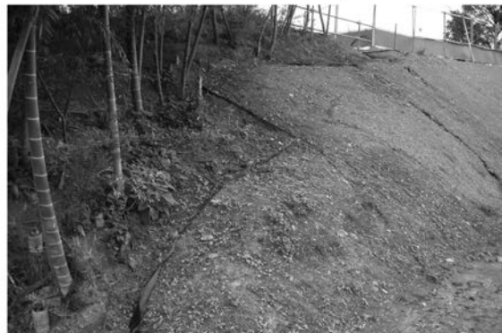
4 バンブーバリア設置完了状況
