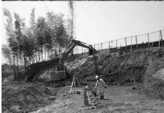
5 施工面成形掘削工
