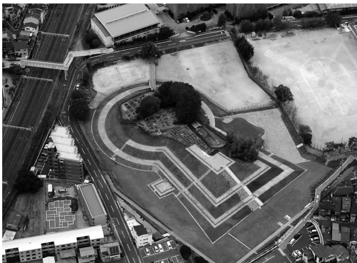
(2) 平成 26 年 保存・整備完成状況（南西から）
