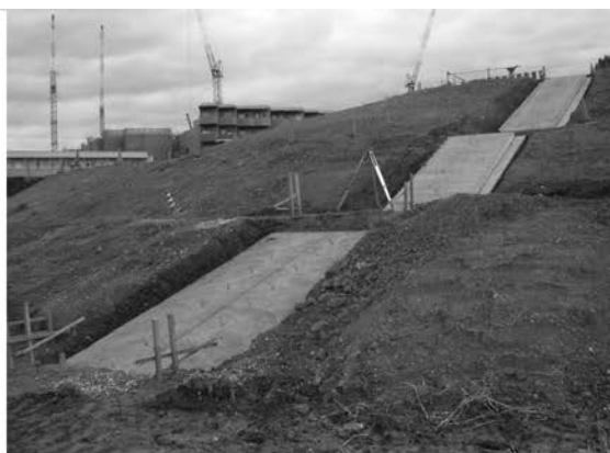
2 石階段裏面施工
