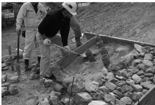
7 葺石復元（植栽植え付けポイド配置）
