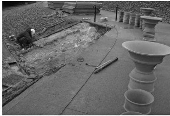
2 西くびれ部葺石復元工-1
