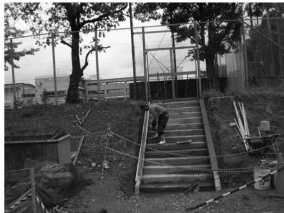
6 同左階段の整備工
