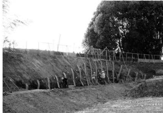
6 裏面排水施設設置工
