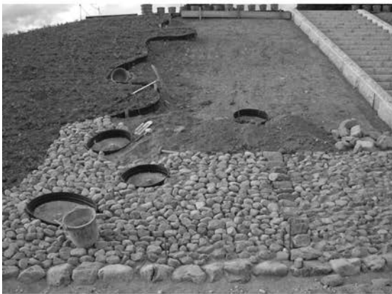
5 葺石積み上げ作業-1
