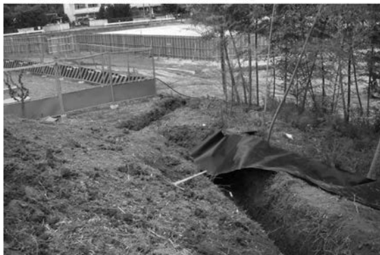
3 バンブーバリア埋め込み工
