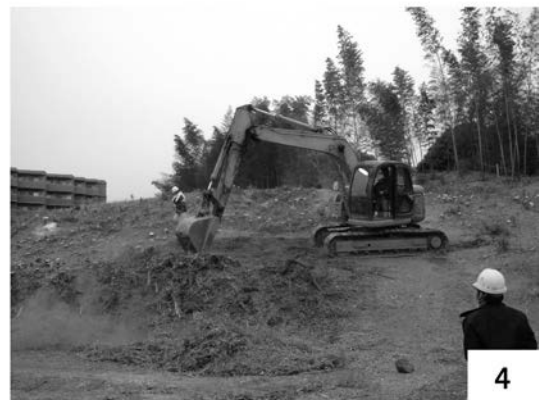
第77図 保存整備工事その1 前方部の竹木伐採除根作業風景
