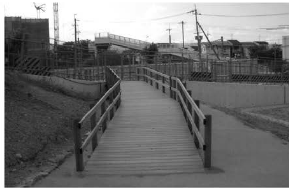
3 東木道スロープ (東から)
