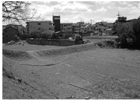
第29図 西堤既存状況（北から）
