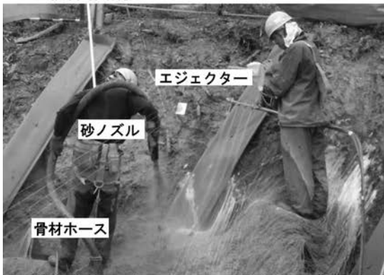
11 繊維噴射エジェクターと砂噴射ノズル
