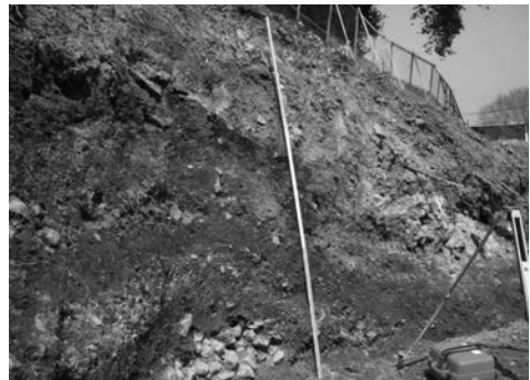
第47図 ジオファイバー基礎工 北壁面中世礫層
