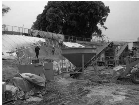
2 施工機械類設置状況
