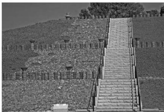
6 石階段完成状況
