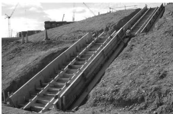
3 石階段コンクリート基礎工
