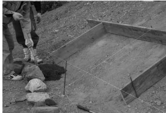
4 葺石復元（基底石設置）
