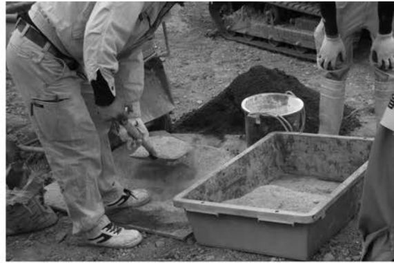
2 二和土作り（消石灰と砂の混合）
