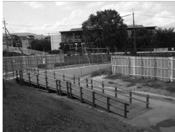
5 東木道スロープ設置状況 (南から)
