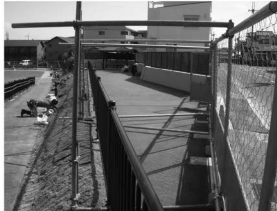
4 舗装整備状況
