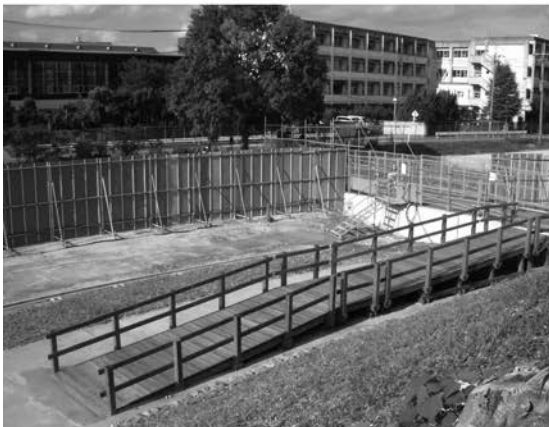
4 西木道スロープ設置状況 (南西から)
