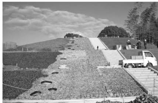
8 葺石積み上げ作業完了状況
