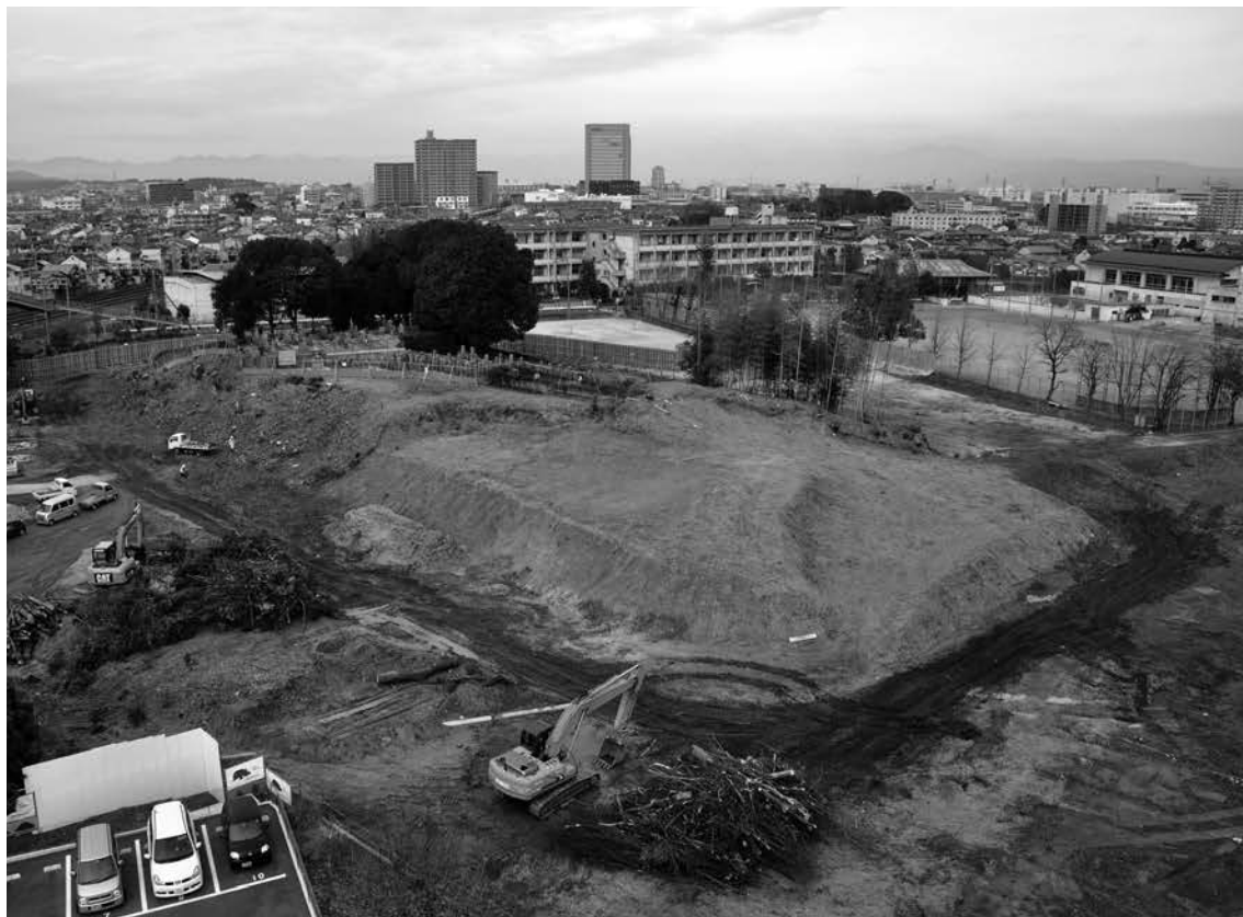
(1) 平成 24 年恵解山古墳保存整備工事その 2 竹樹木伐採状況全景（南西から）
