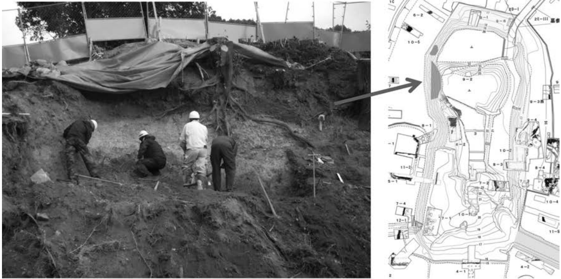
整備工事に伴う埋蔵文化財調査
