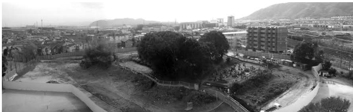
(3) 平成 24 年恵解山古墳保存整備工事その 2 竹樹木伐採状況全景（北から）
