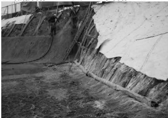
13 連続繊維補強土工-4
