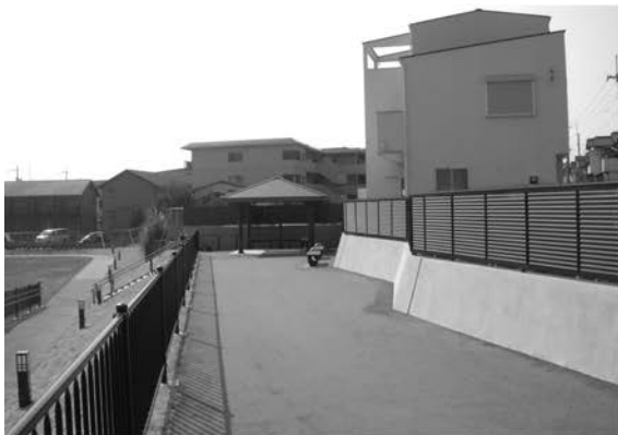
5 休憩広場完成状況
