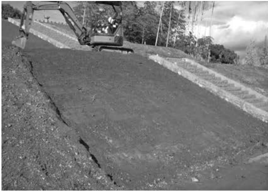
1 前方部前面葺石復元工掘削-1
