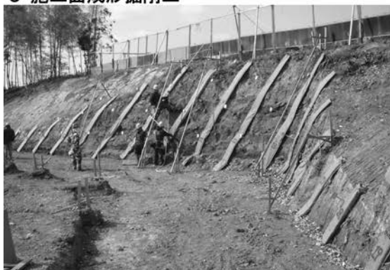
7 プレートアンカー設置工
