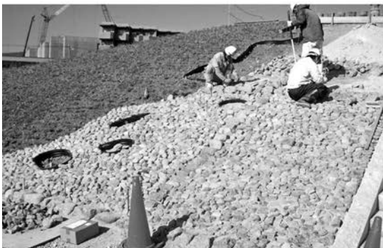
7 葺石積み上げ作業-3
