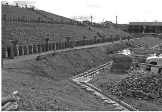
1 西くびれ部葺石復元工着手前
