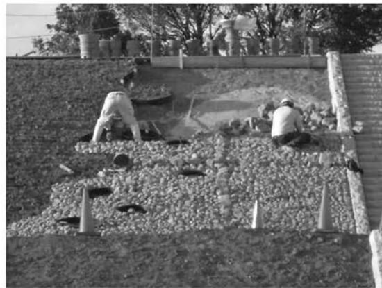
6 葺石積み上げ作業-2
