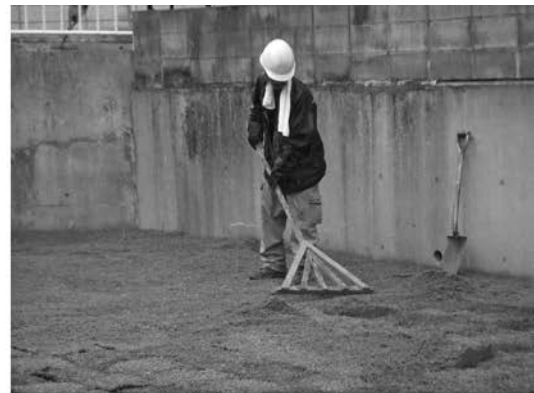
2 芝張り工 周濠南東隅部-2
