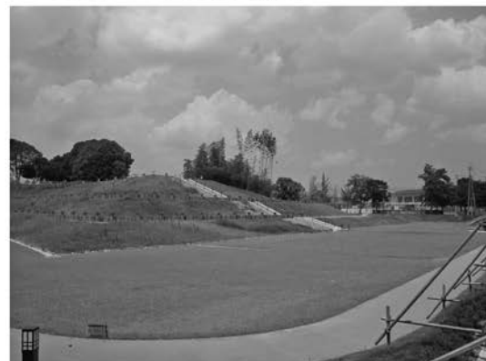
4 前方部前面周濠の芝張り状況
