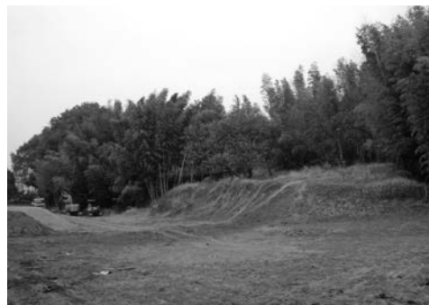
第32図 西堤撤去状況（南から）
