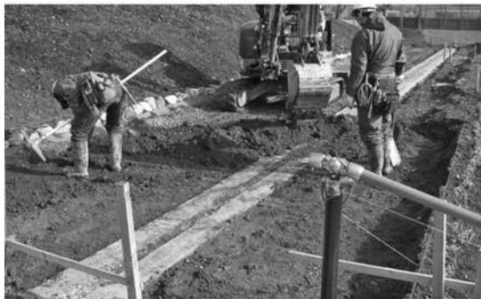
3 埴輪列設置コンクリート基礎完成
