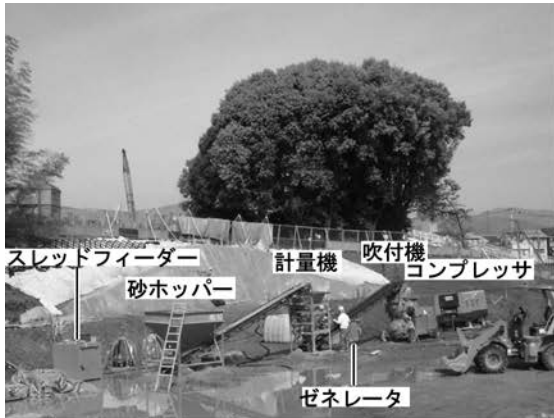
1 ジオファイバー施工風景（南東から）
