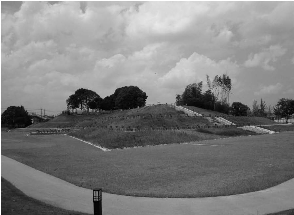
(1) 墳丘西辺の保存整備完成状況（南西から）
