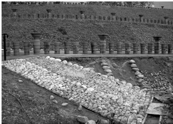
3 西くびれ部葺石復元工-2
