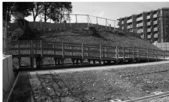
7 西木道スロープ設置状況 (北から)
