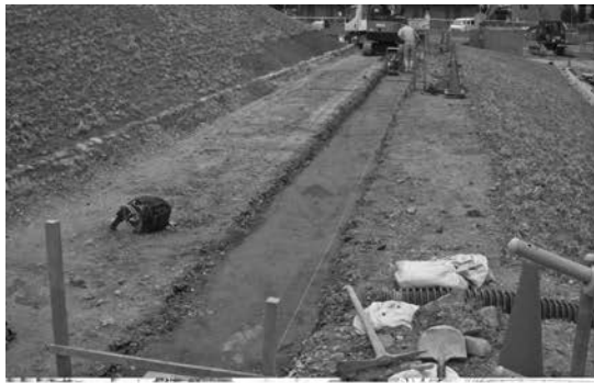
1 埴輪列基礎掘削工
