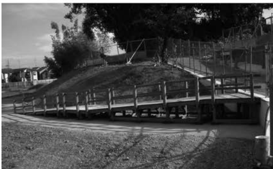
6 東木道スロープ設置状況 (北から)
