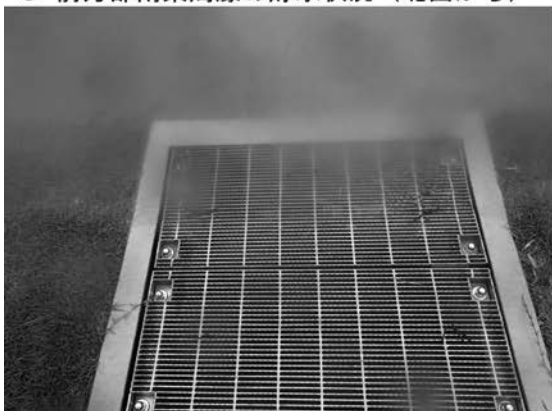
7 オリフィスの排水機能状況（南東から）
