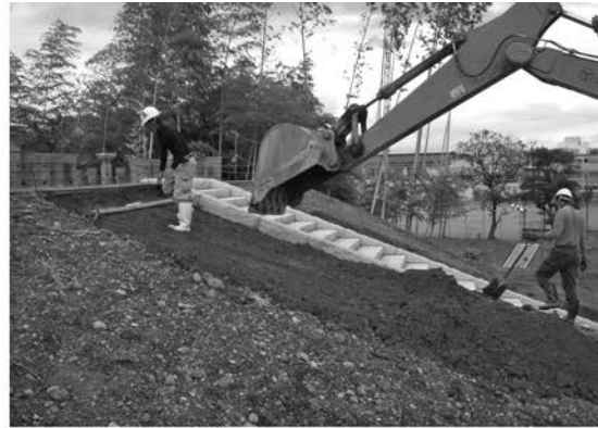
2 前方部葺石復元工掘削-2
