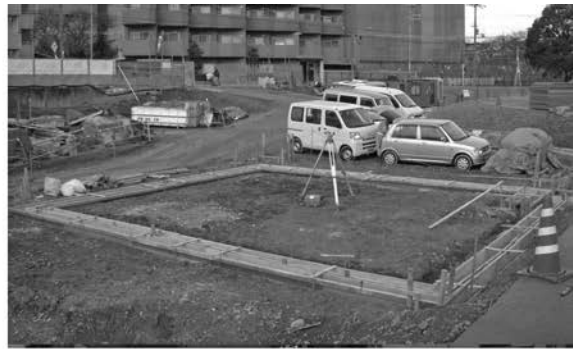
2 埴輪列基礎型枠
