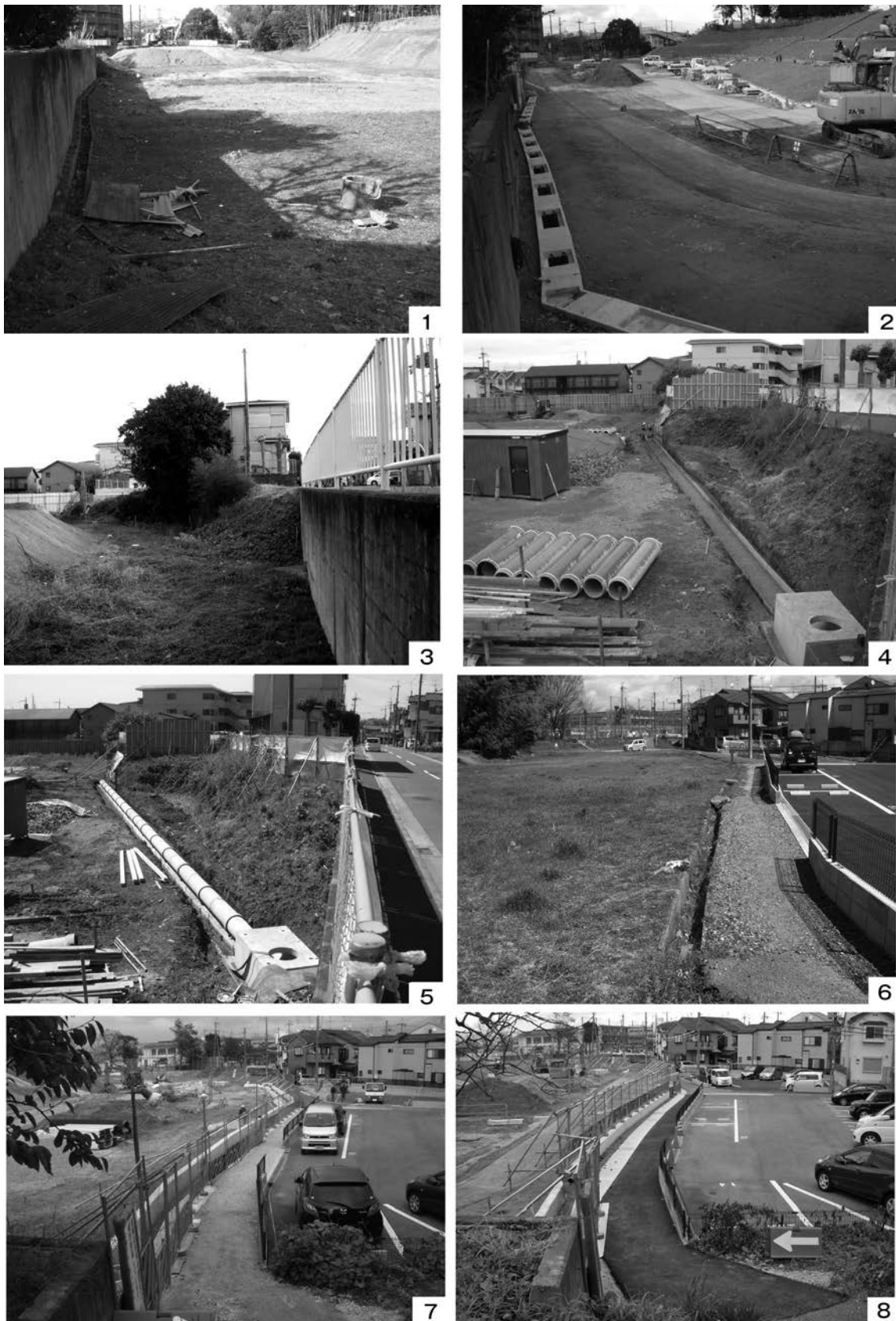
第83図 西辺・南辺排水路改修工
