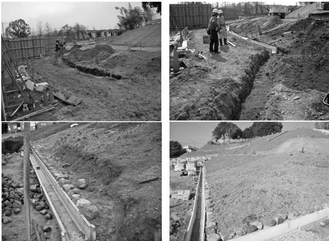
第82図 墳丘裾水路設置工
