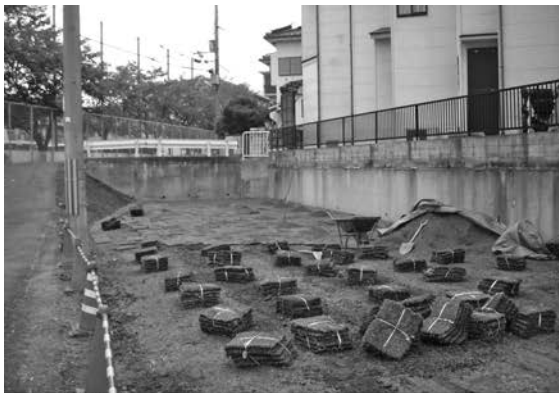
1 芝張り工 周濠南東隅部-1
