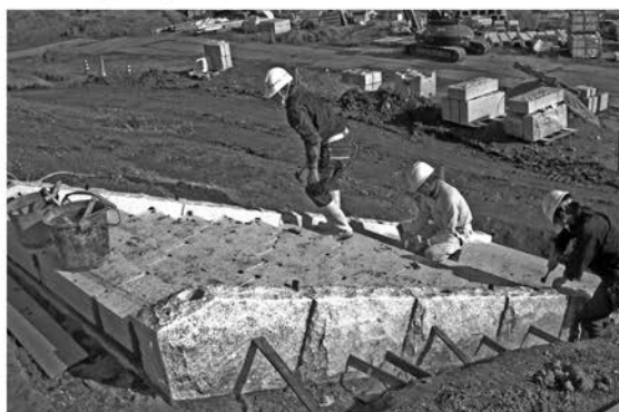
4 石階段取り付け工
