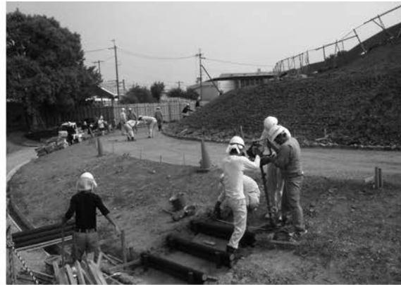
2 擬木階段設置工
