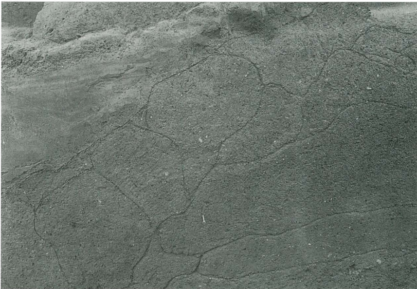
2. 墳丘南側裾部分 の断面，俵状に 盛土されている
