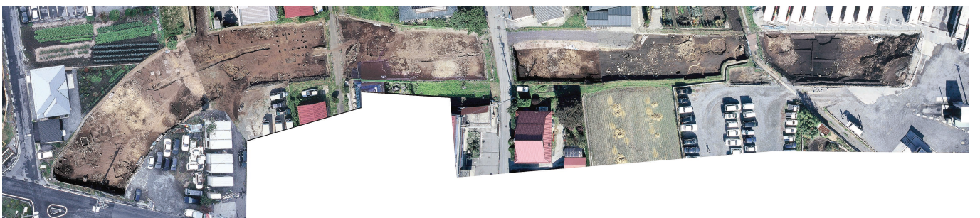
構井・阿弥陀堂遺跡調査区全景
