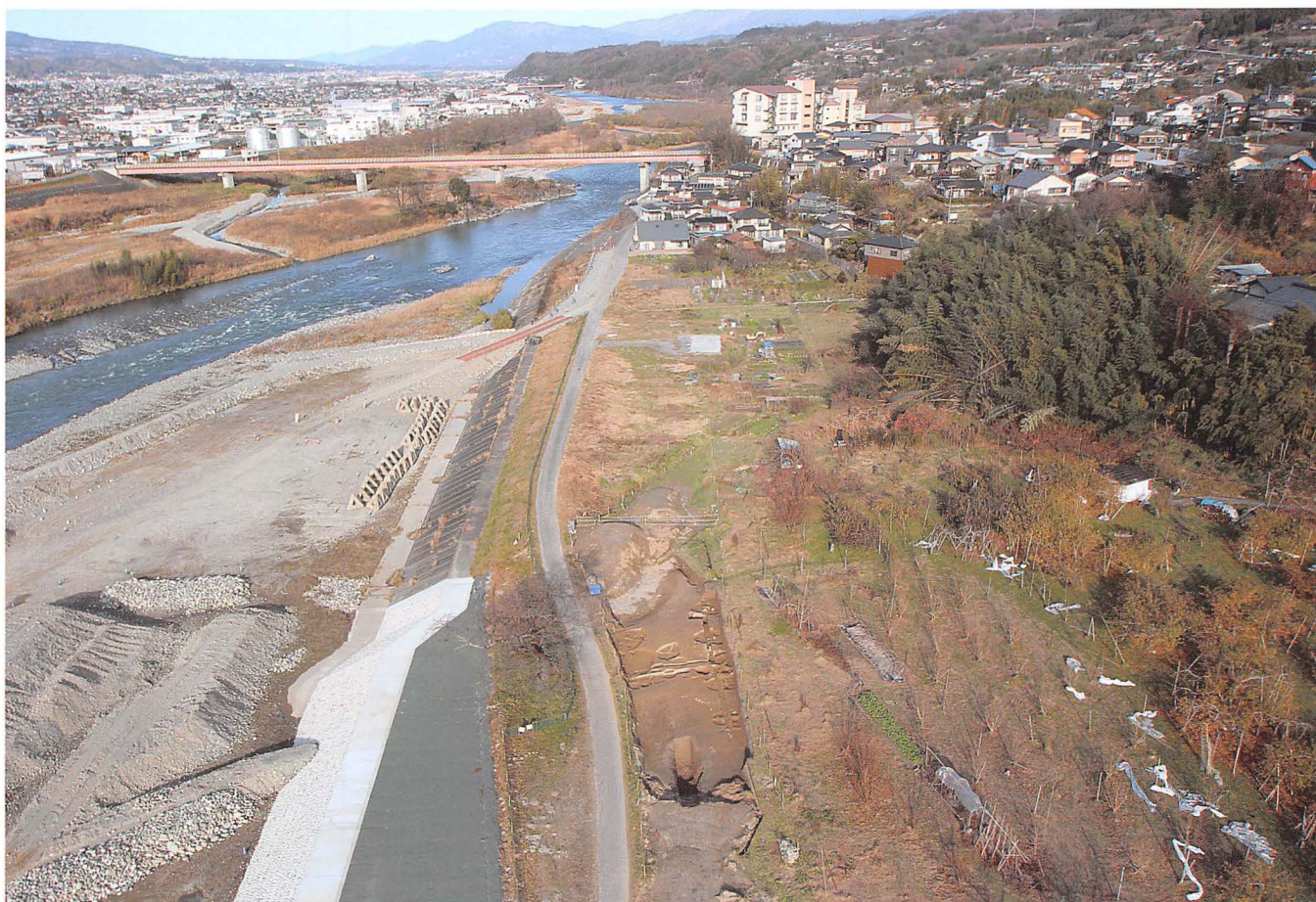
飯田市 川原遺跡 調査区遠景
