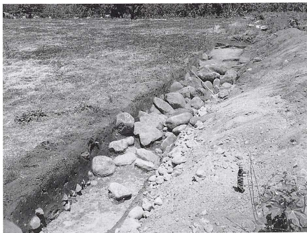
図 13 トレンチ掘削状況（南から）
