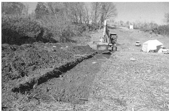
図48 トレンチ掘削状況
