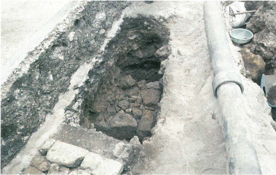
基壇状南遺構検出状況 (東より)
