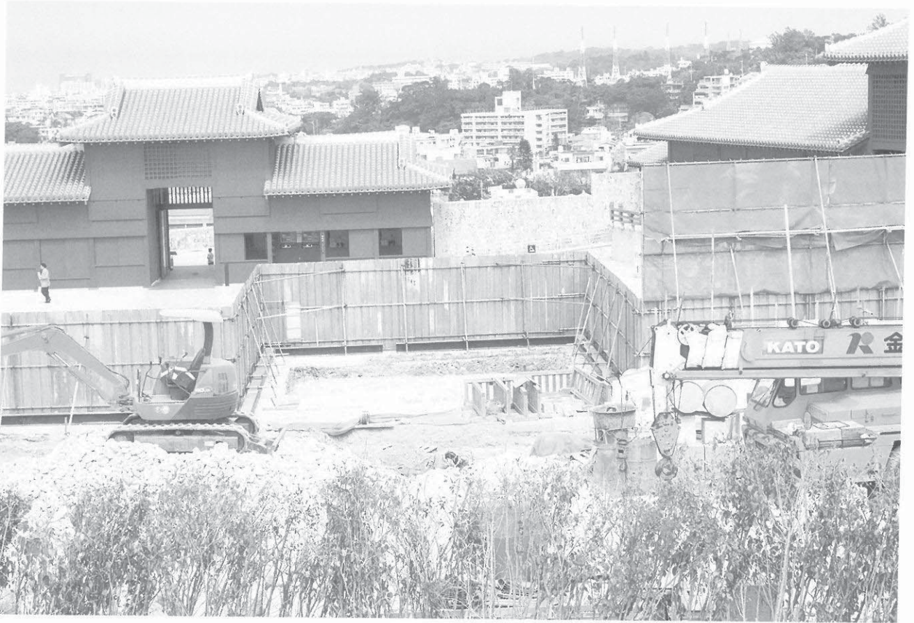
図版1 調査前の状況（南から）
