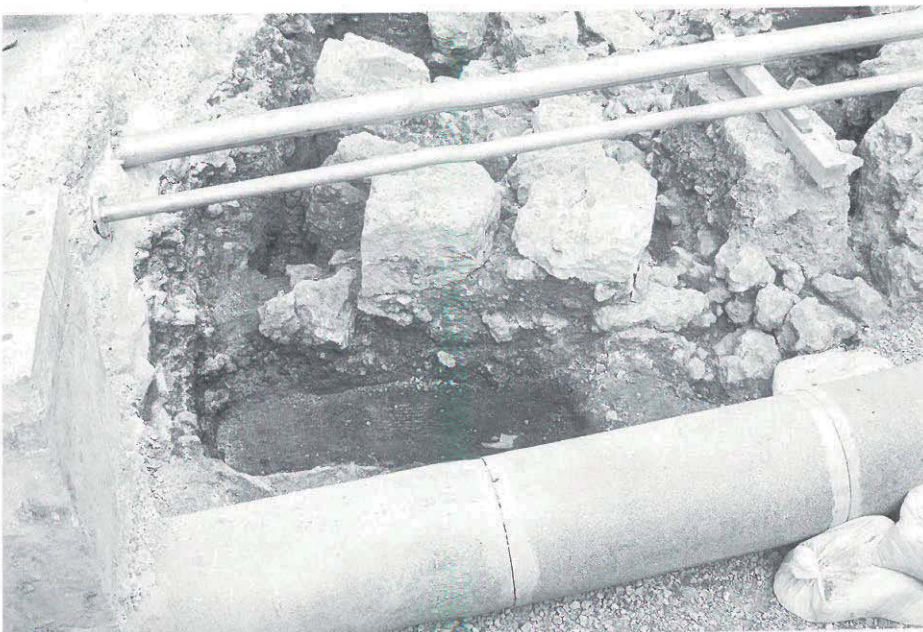
図版6 上部石積み・下部古石積み検出状況
