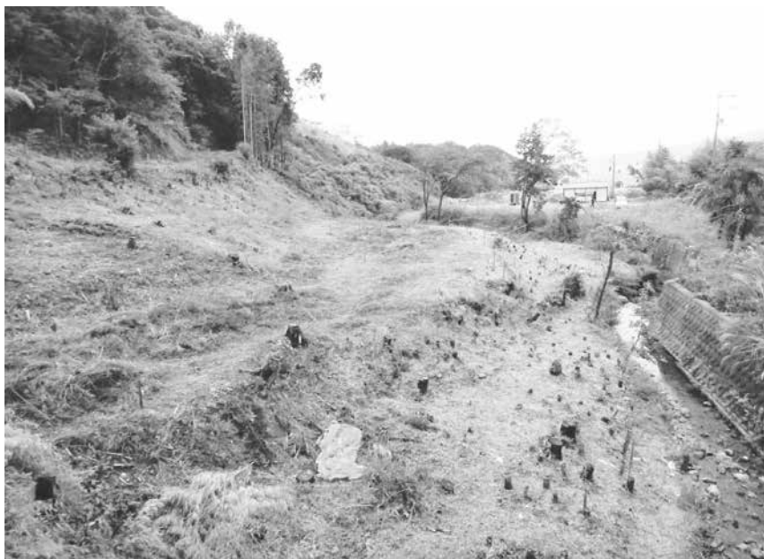
3. 2次3区草刈後の状況（北から）
