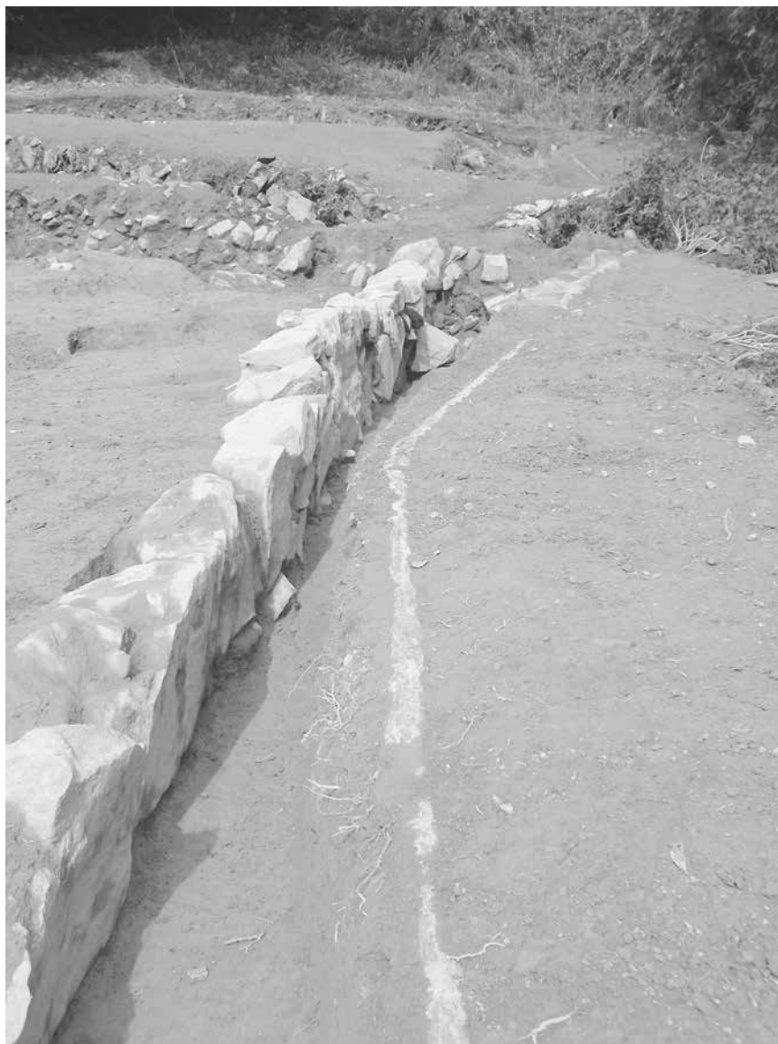
1. 1次2-1区 331 石垣石積状況（南東から）
