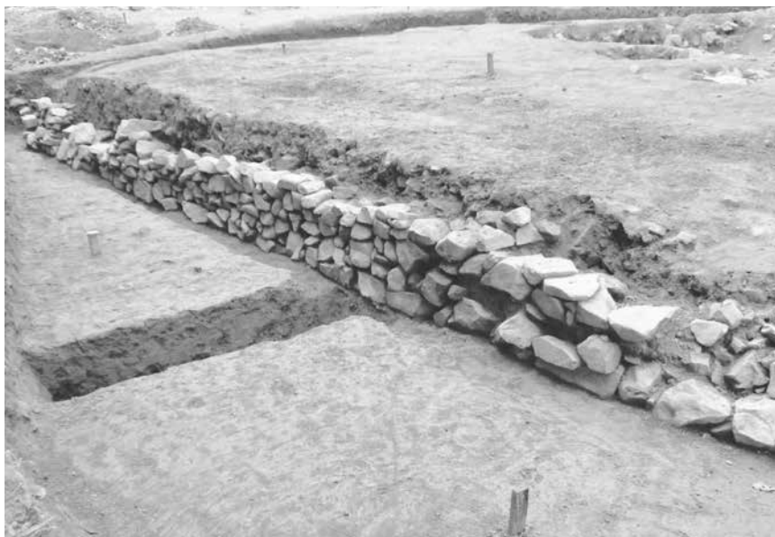
1. 1次2-1区 323 石垣 (北東から)
