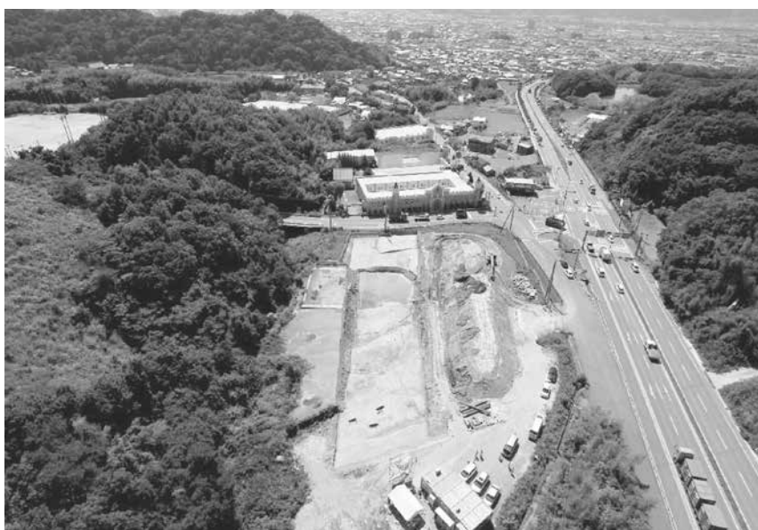
2. 1次1区調査地遠景(南西から)
