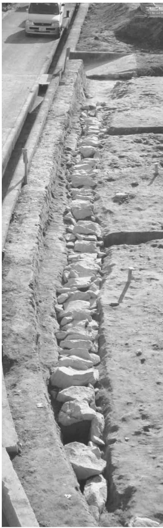
1. 1次2-2区317暗渠 (北東から)
