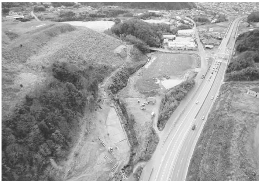
1. 2次調査地遠景（北西上空から）
