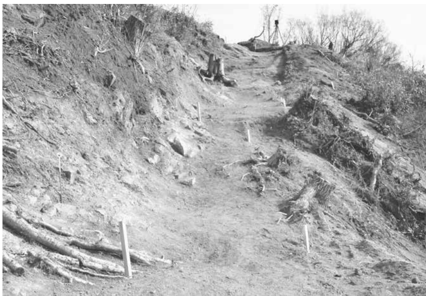
2. 2次5区中央部掘削完了後 （北西から）
