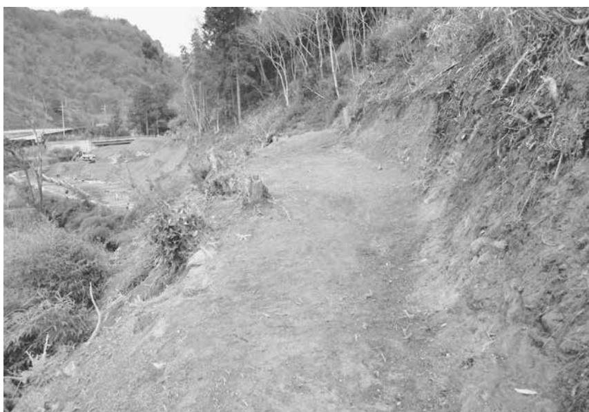
2. 2次4-1区中央部掘削完了状況 （南から）
