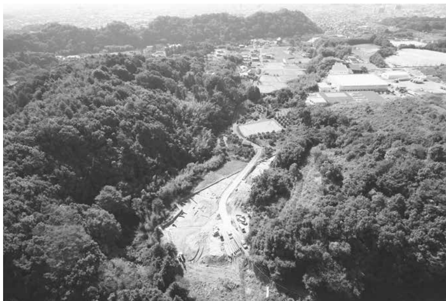
1. 1次2区調査地遠景 (北上空から)
