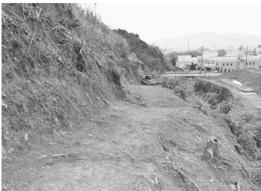
3. 2次4-1区南側掘削完了状況（北から）
