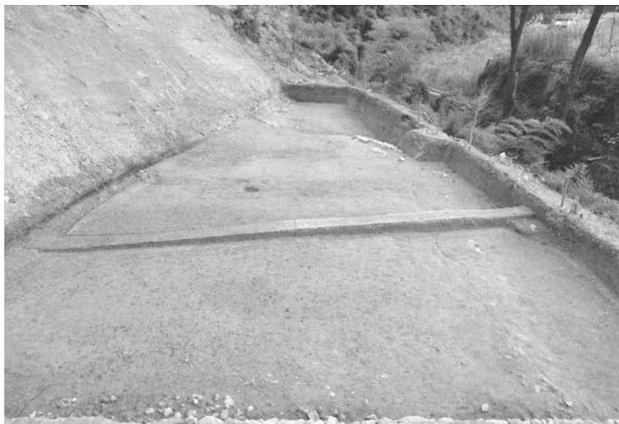
1. 2次3区南半部遺構検出状況 (北から)
