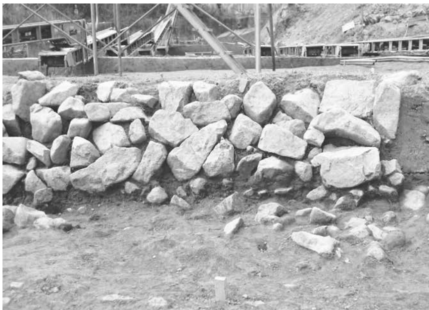
3. 2次3区1石垣石積状況 （南東から）
