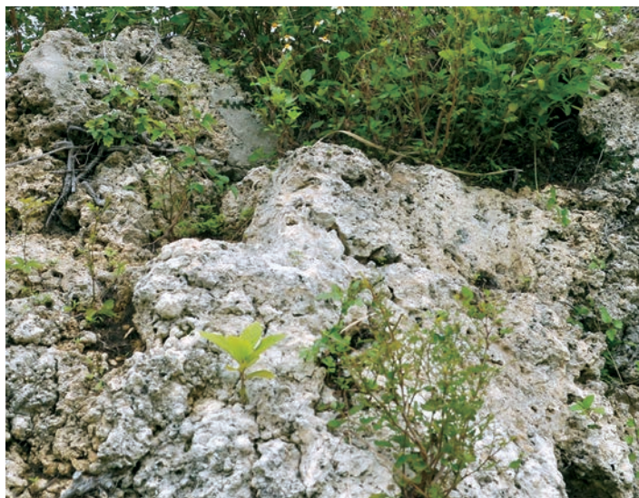
図版155 大岩の上部に残る階段状のはつり痕(南より)
