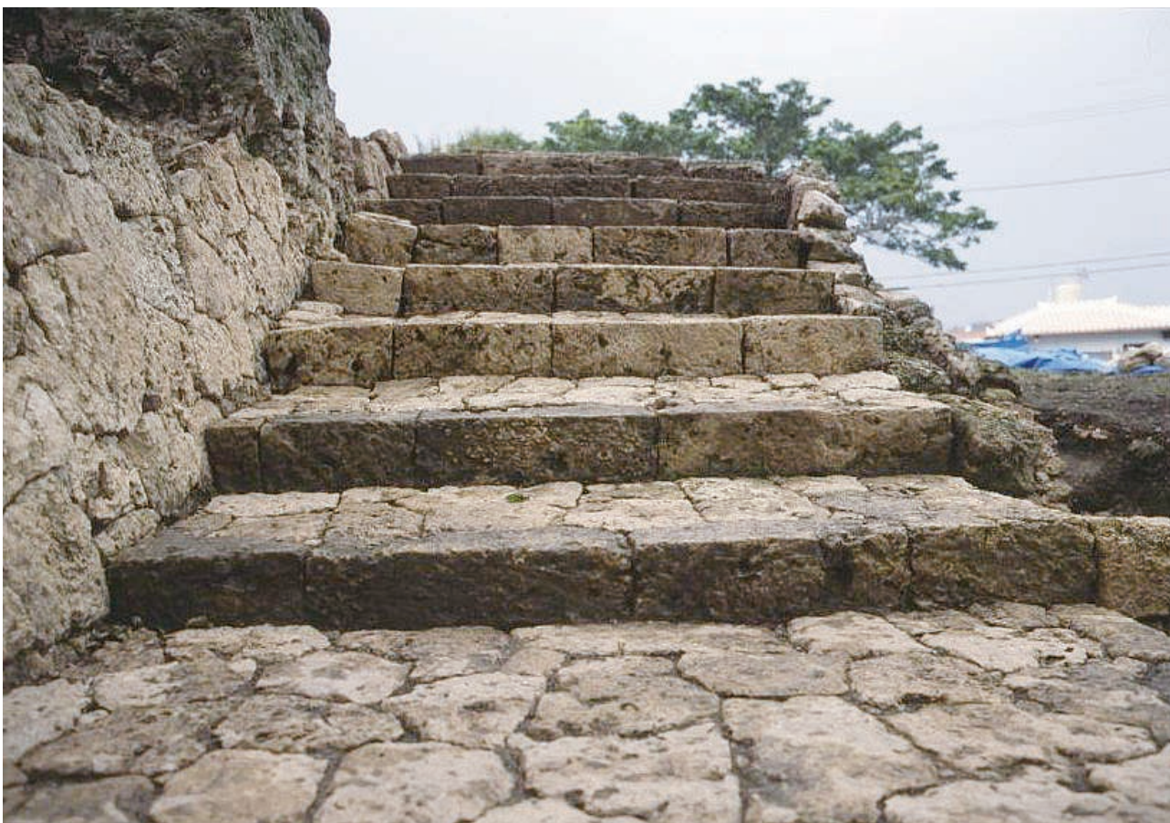
4. 階段跡立面（南から）
