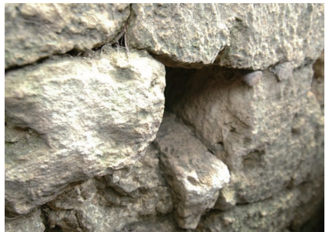
2. 石牆東面暗渠拡大(南東から)
