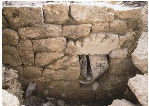
3. 暗渠石積み立面 (西から)
