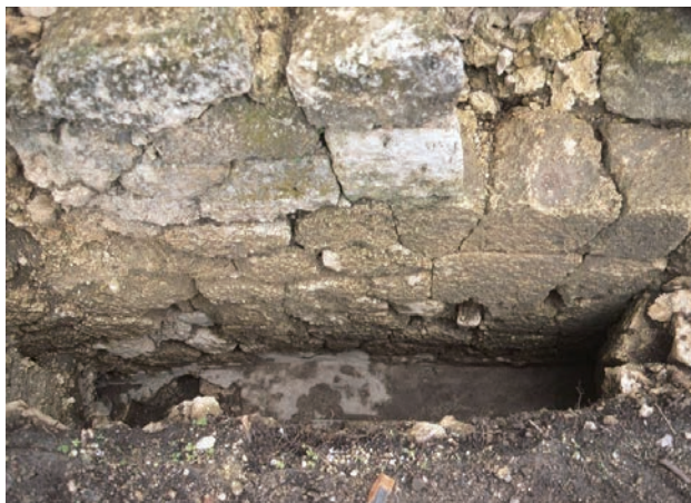
1. 石牆東面暗渠と開渠2
