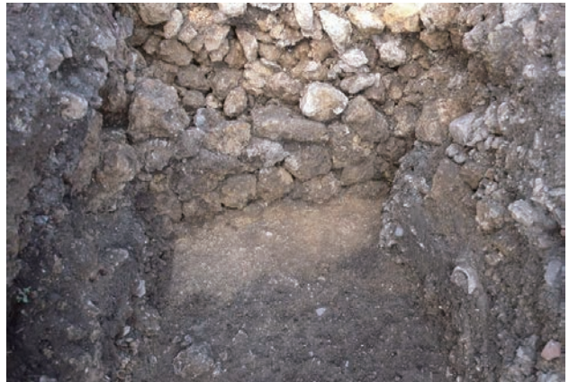
4. 石積み2 立面 (東から)
