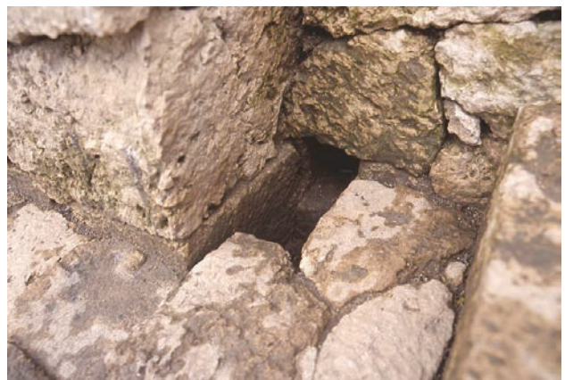
5. 門跡南側暗渠取水口拡大（北西から）
