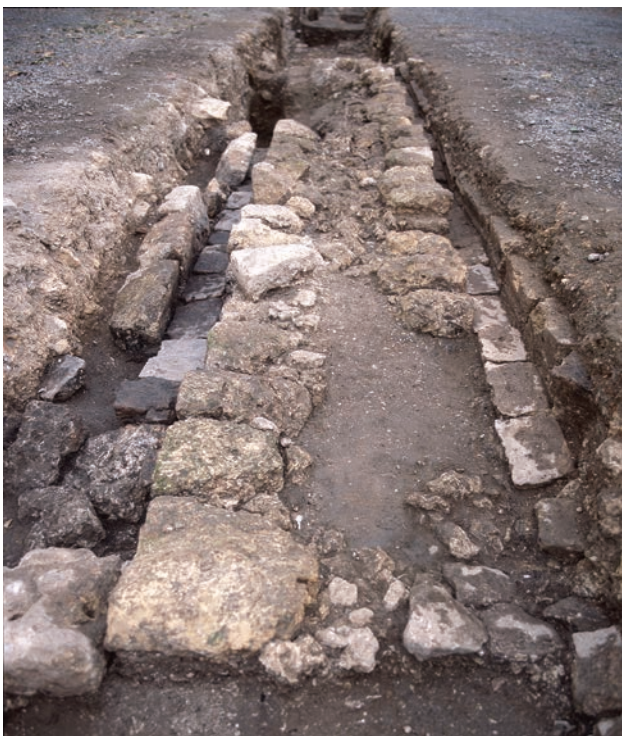
2. 溝6・7、旧石畳2検出状況 (西から)
