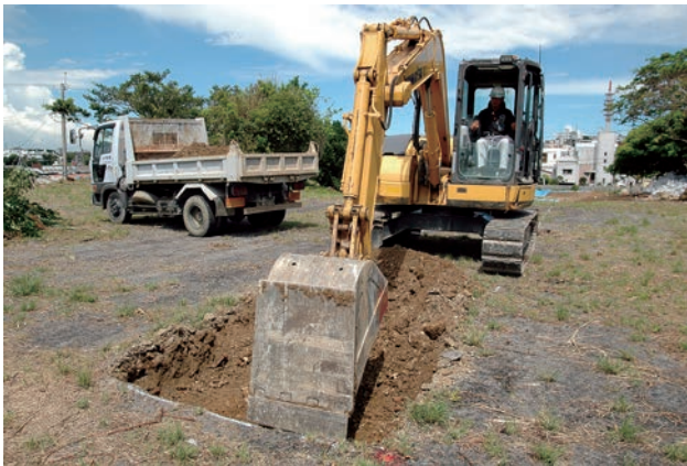
3. 表土除去作業
