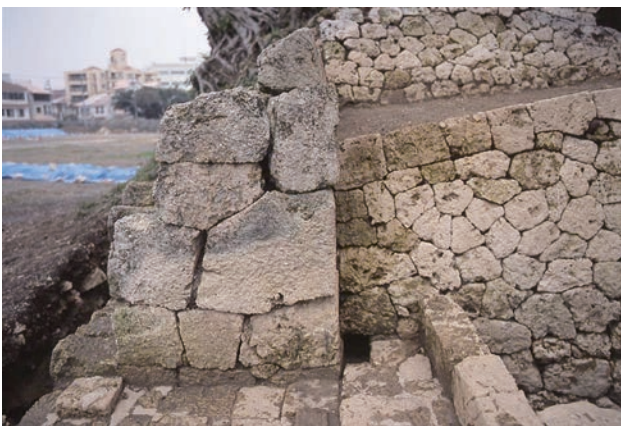
4. 門跡南側暗渠取水口（画像中央下・北から）
