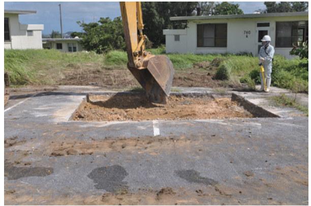
重機掘削作業
