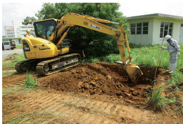
重機掘削状況
