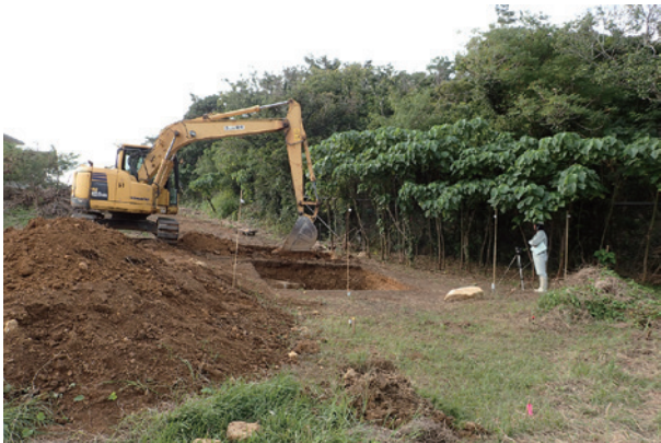
確認トレンチ重機掘削
