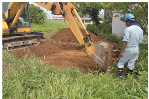
重機掘削作業
