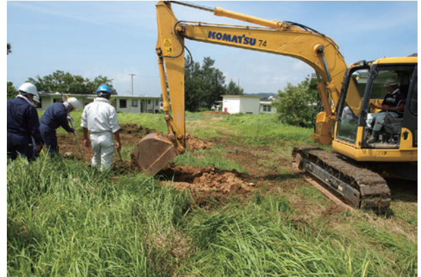
重機掘削作業
