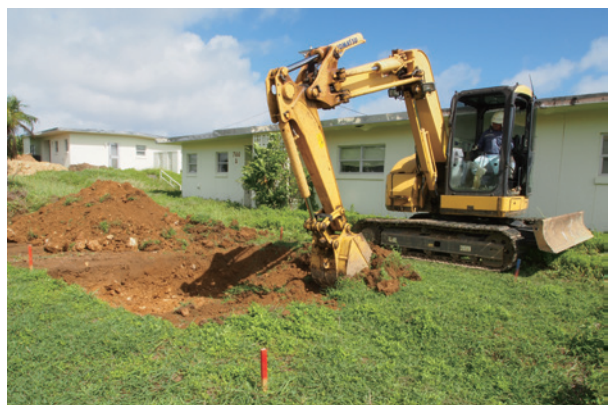
重機掘削状況
