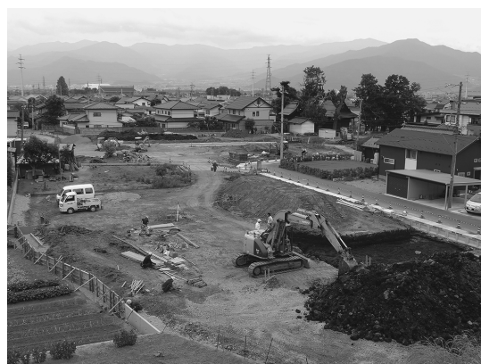
3区表土除去（北西から）
