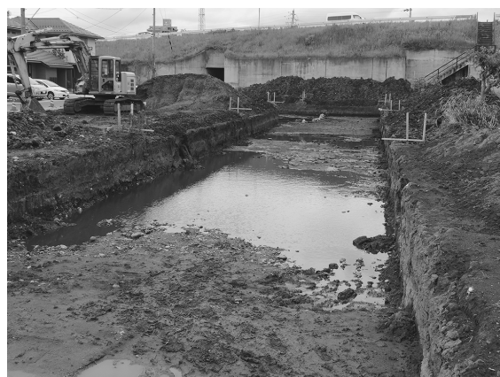
3区流路検出時（北東から）
