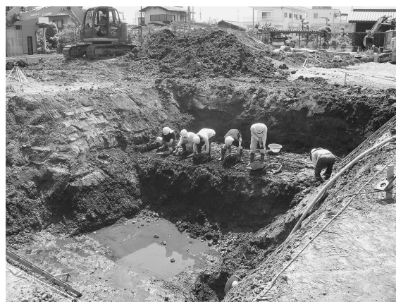
作業風景（北東から）
