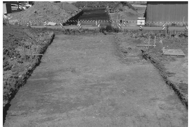
1区西、3区東側（東から）
