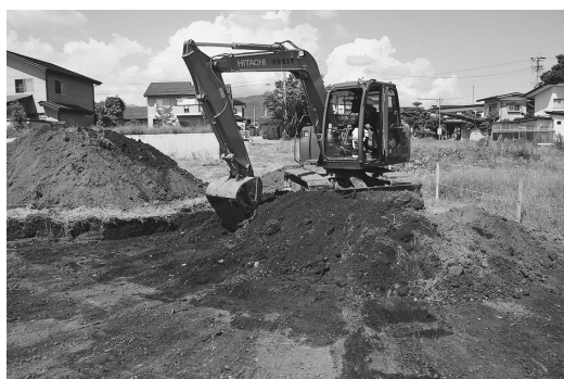
写真1 第1調査区表土掘削作業（9月2日）
