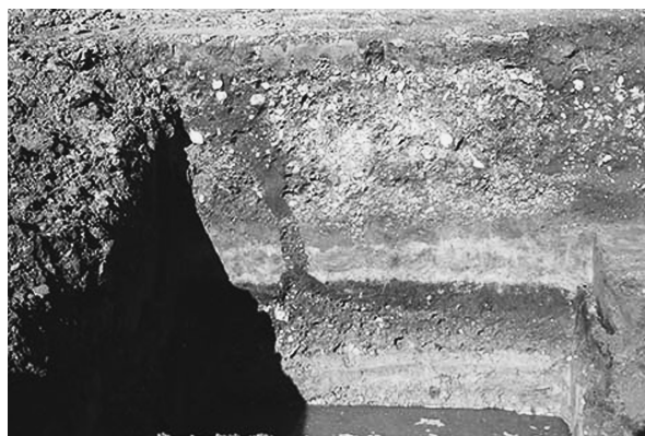
噴砂痕確認トレンチ (南東より)
