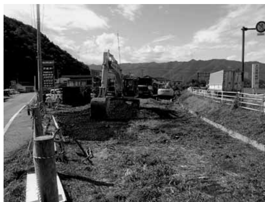
写真1 1次面表土掘削作業（8月11日）
