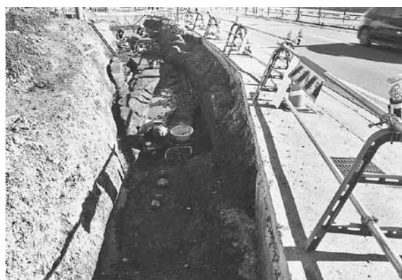
A区作業風景（西から）
