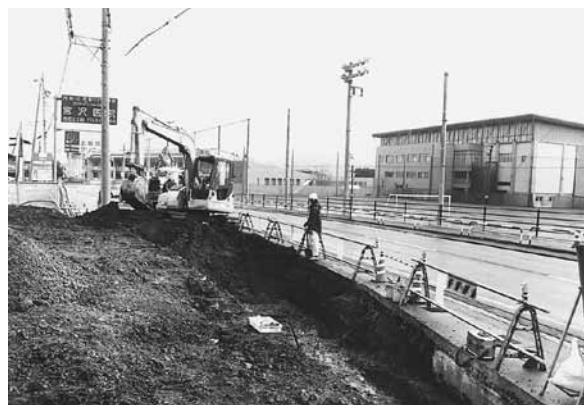
A区表土除去作業（西から）
