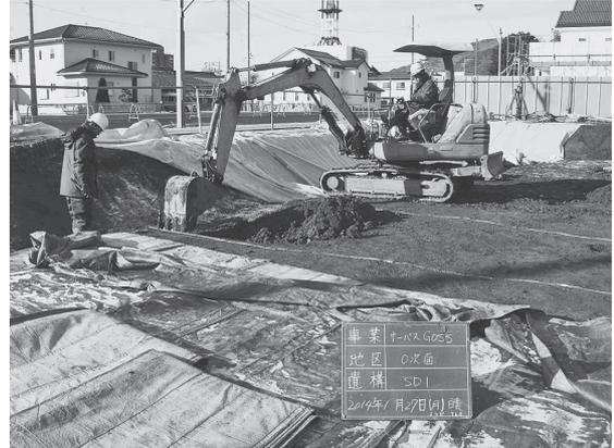
写真1 表土掘削作業（1月27日）
