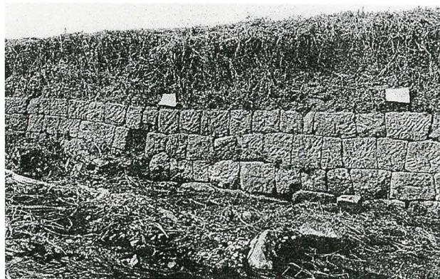
殿様湯跡前の二反田川の川岸には、天保14年(一八四三)に造られた石積みみの堤防が築かれています。当時は二反田川の河口から、約3キロにわたって7段の石積みが続いていました。試算でも約6万個の石が必要になる大工事です。島津の殿様は、やかた舟で殿様湯に湯治に来ていて、水量の少ない二反田川に舟が入ると地元の人々が両岸から舟をひっぱって殿様湯まで運んだとの伝承が残っています。
