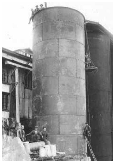
(写真 60) 増設工事中のパチェカタンク
