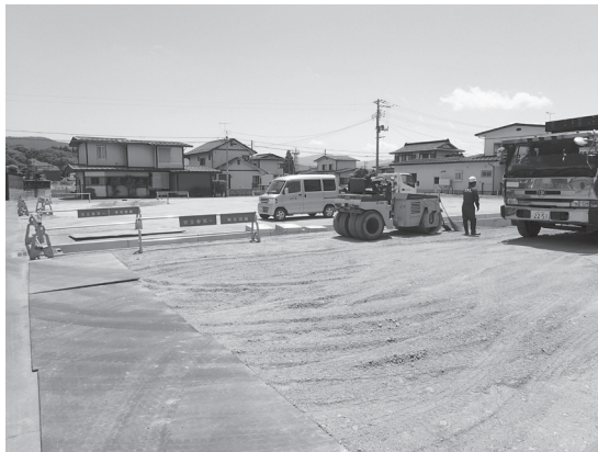
二色根字起田 工事状況 (西から)
