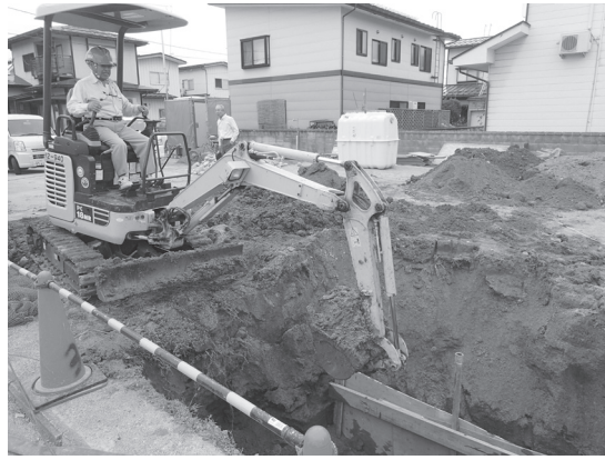
高梨字畑田 工事状況（東から）
