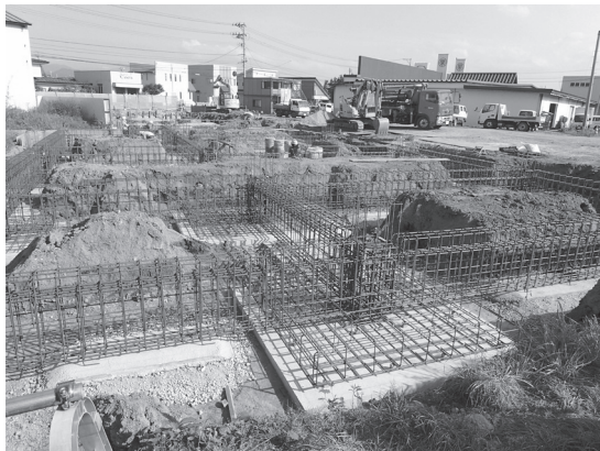
長岡字清水尻 工事状況 (西から)
