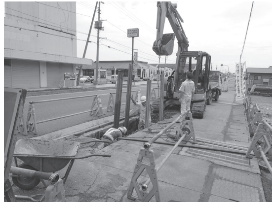
北町遺跡隣地 工事状況 (北から)
