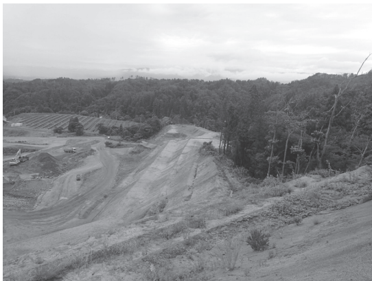
土平地区岩石採集場 (西から)
