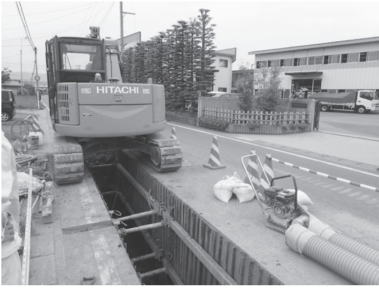
内城館跡 工事状況（西から）
