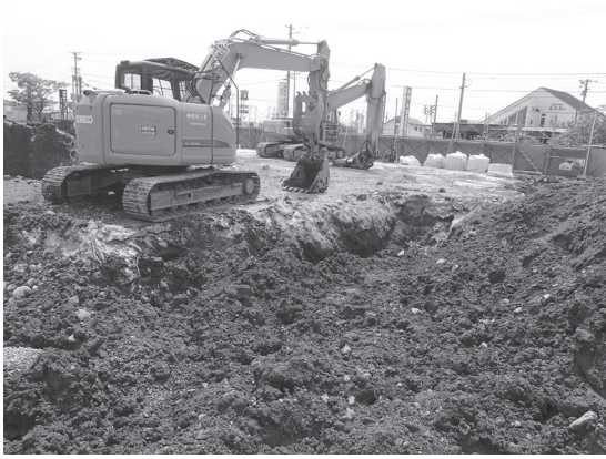
唐越遺跡工事立会（東から）
