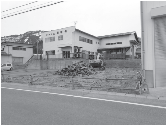
川樋字五十匁調査地（東から）
