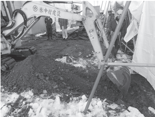
萩生田遺跡 工事状況（西から）
