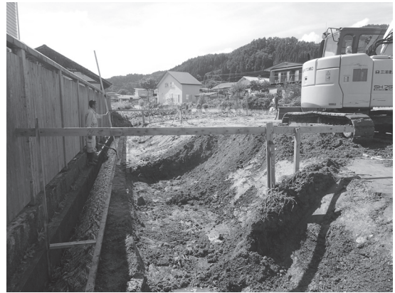
宮内字大壇 掘削状況 (東から)
