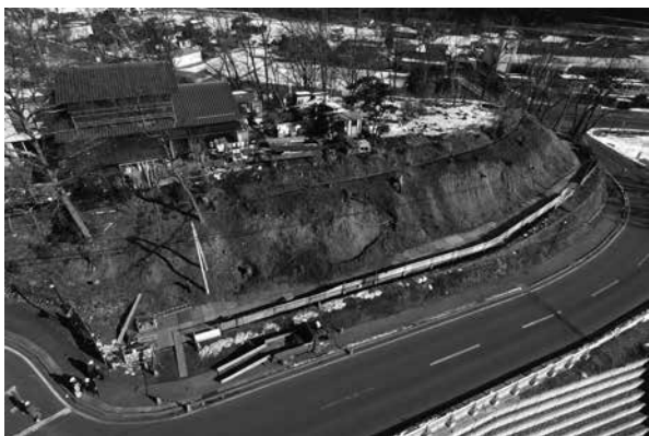
モルタル吹付け施工面（南西から）
