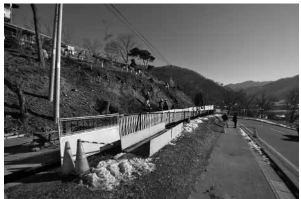
モルタル吹付け施工面（西から）
