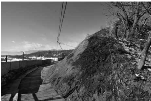
モルタル吹付け施工面（東から）
