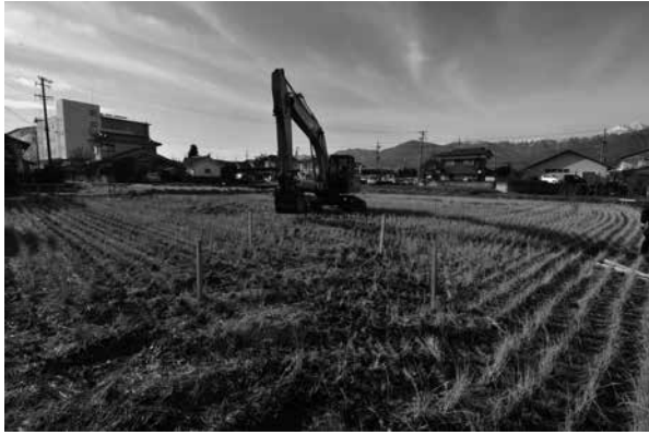
A区調査前（北東から）
