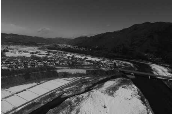
狐城遠景施工前（南から）
