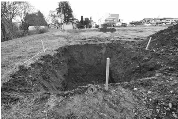
B区（北から）
