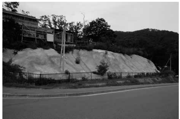
モルタル吹付け工事施工後（南西から）
