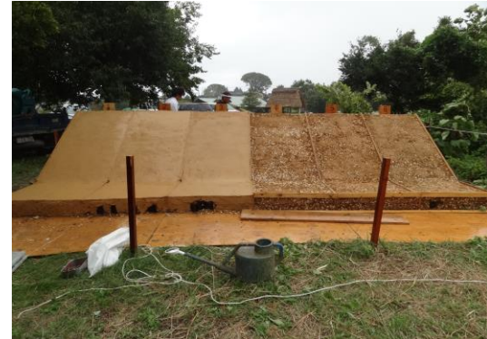
写真 6 表層土仕上げ・上層土転圧後
