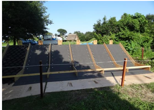
写真 2 不織布・アンカーピン敷設 屋根試験体は左端から①→⑥
