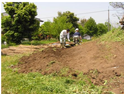
写真4 土屋根下部の土の削り取り
