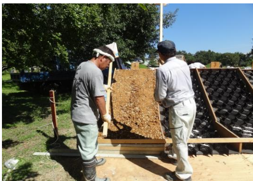
写真 5 上層土転圧（工具転圧面 30×20cm）
