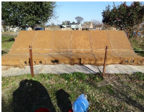
写真7 崩落土堆積状態
