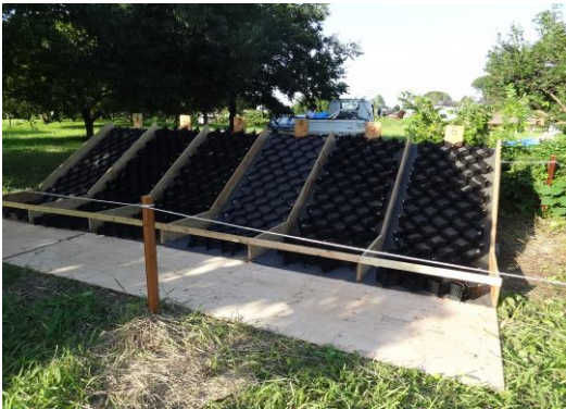
写真 3 型枠敷設
