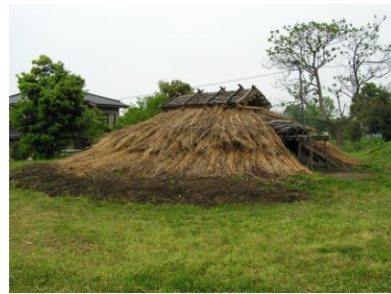
写真3 茅束設置状況
