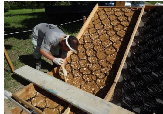
写真 4 下層土転圧（工具転圧面 \phi 10cm）
