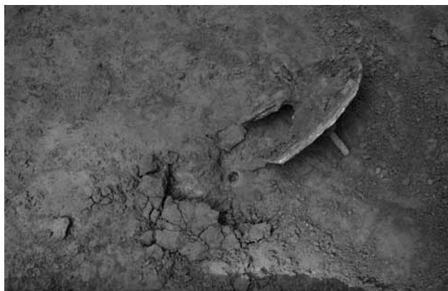
埋設されていた電柱の支線の先端
