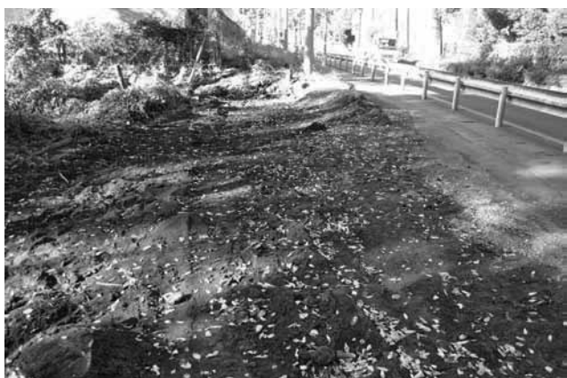
埋め戻し後の風景（南東から）
