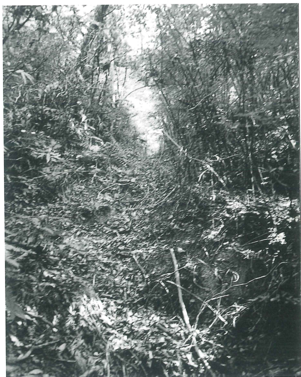
写真7 堀切と掻き揚げ土塁 （北西より、右側が土塁）
