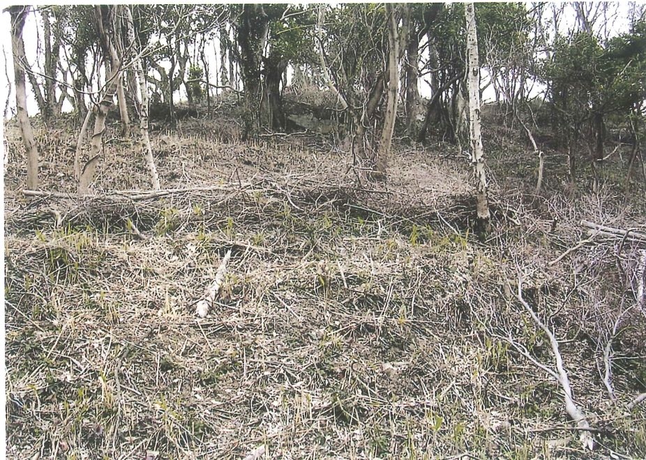
北西斜面より本丸を見上げる（北西より）
