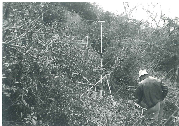
写真3 GPS観測による登記基準点の設置
