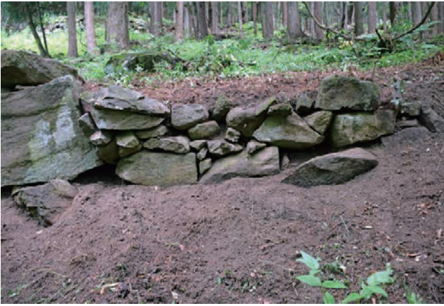
石積 10 石積の状況
