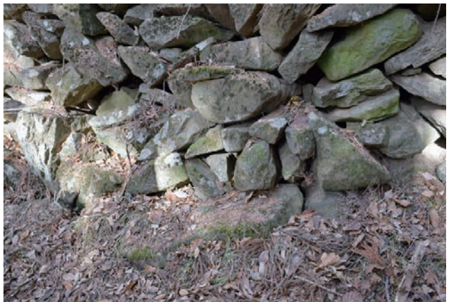
石積 40 根石付近の状況（東半）
