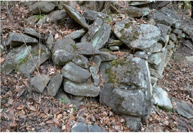
石積3 (トレンチ3) 隅角部の状況
