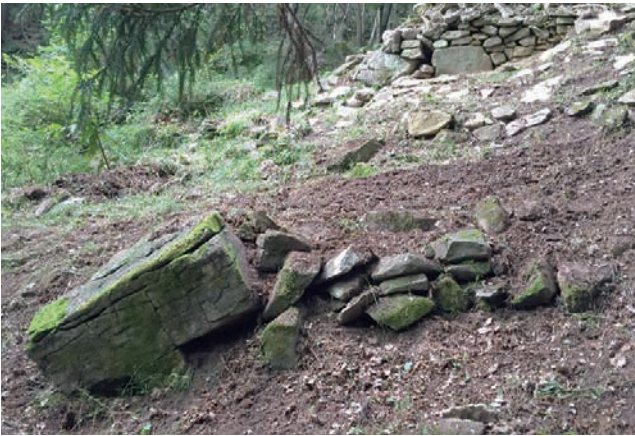
石積 33 大石と石積みの状況
