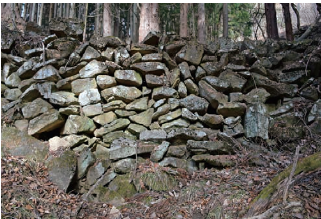
石積 40 石積みの状況（中央）
