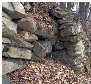
図6 桐原城跡段郭石積の控積み
