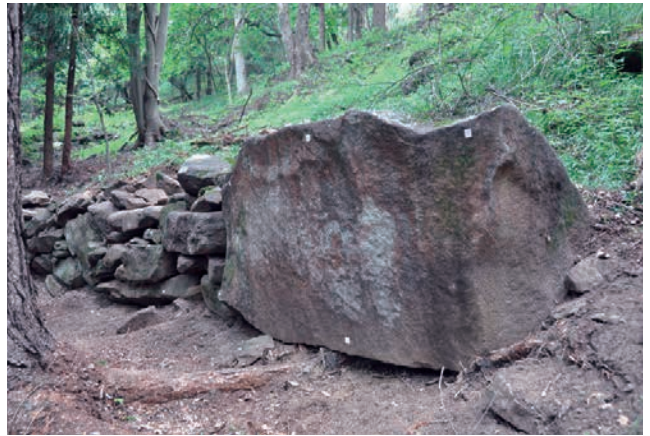
石積 17 東隅の大石使用状況
