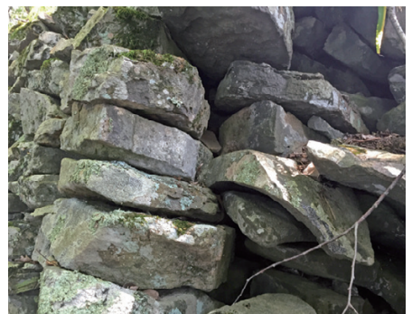
図7 青柳城跡主郭石積の控積み
