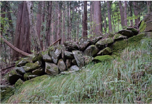
石積 15 西端部築石の状況 (縦石使い)
