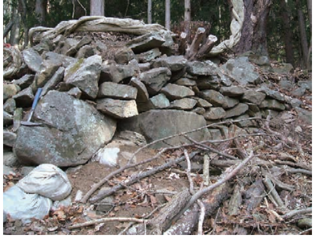
2. 石積6(トレンチ3)
