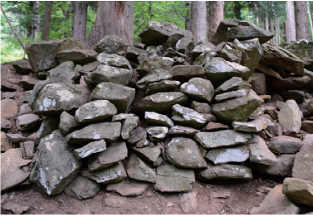
石積 12 (トレンチ 19 西方)
