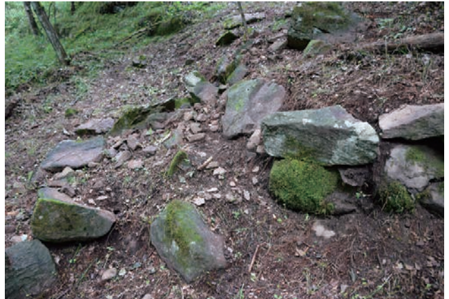
石積9 西端部と土塁9の接続状況
