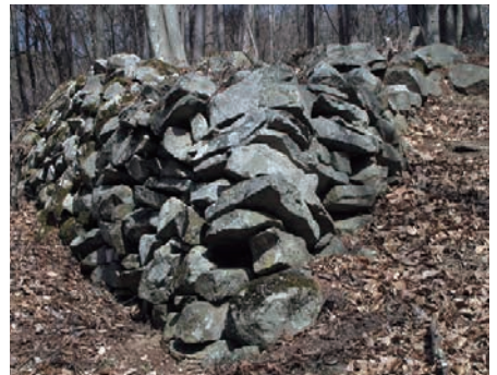
図4 桐原城跡段郭石積の隅角部
