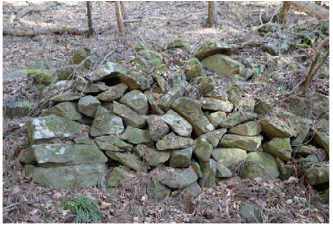
石積 15 南面の石積みと隅角部の状況
