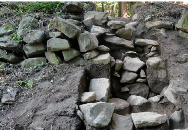
石積6 (トレンチ 4) 前面石積と控積みの状況
