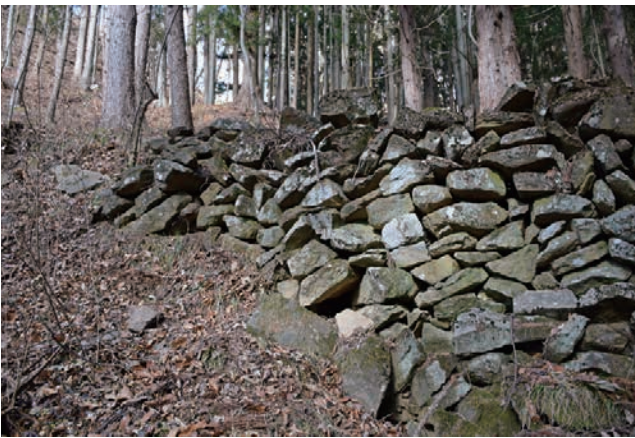
石積 40 石積みの状況（西半）
