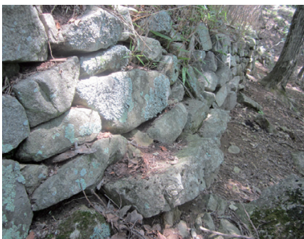
図5 埴原城跡主郭石積のアゴ止め石
