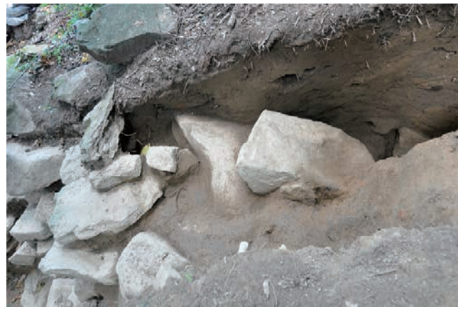
石積6 (トレンチ 4) 控積みと裏込めの状況
