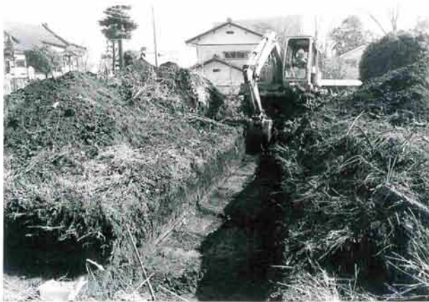
本村南遺跡調査風景
